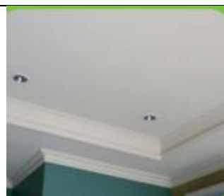
Figura 97: tumbado de Gypsum Fuente: Edimca (2017)
