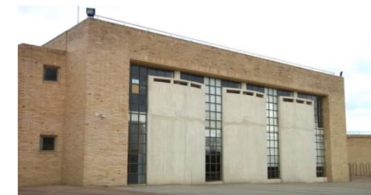
Figura 16: fachada – CDC El Porvenir Fuente: Fonade (2011)
