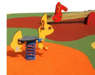
**Figura 107:** pavimento continuo de caucho
