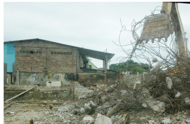
Imagen 10: Limpieza de escombros, varillas de acero y concreto
