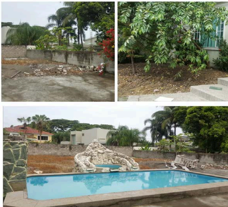
Gráfico 2. Imágenes áreas exteriores sin intervención
