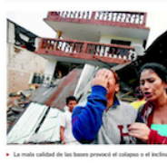
La mala calidad de los bienes provocó el colapso y el deterioramiento de las edificaciones.
