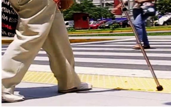
*Figura 81.* Señalización podotáctil. Tomado de “Blog Signo vial – Señalización y Seguridad Vial”.
