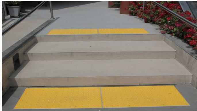
*Figura 82.* Señalización podotáctil. Tomado de “Blog Signo vial – Señalización y Seguridad Vial”.
