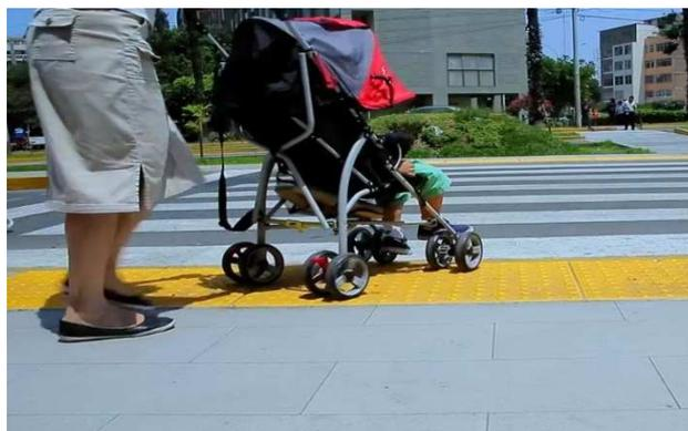
*Figura 83.* Señalización podotáctil. Tomado de “Blog Signo vial – Señalización y Seguridad Vial”.
