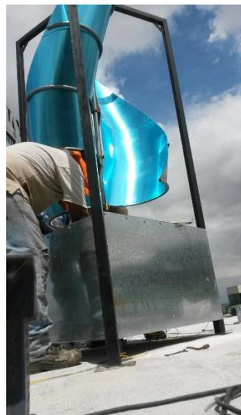
Instalación de la estructura estabilizadora.
