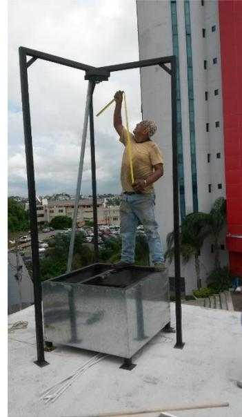
Instalación de la estructura estabilizadora.
