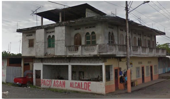
Figura 3.3: Terraza de Casa en Carrizal Fuente: Google maps
