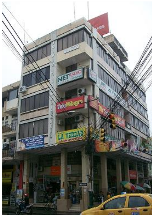
Figura 3.2: Edificio Villavicencio Fuente: Elaborado por Autor
