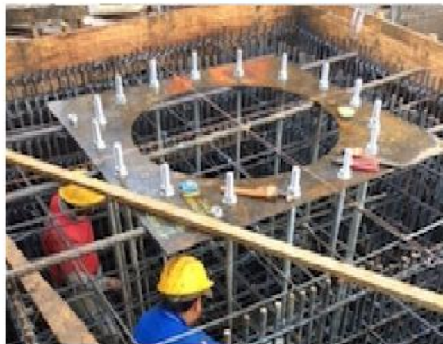
Cimentación para Torre Autosoportada
