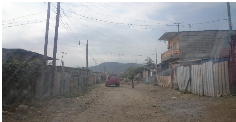
Figura 4. 2: Estado de la infraestructura en algunas calles del sector. Elaborado por: Autor.
