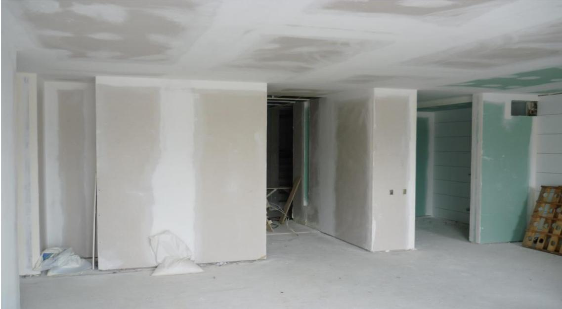
GRÁFICO 14 Paredes de Paneles del Sistema tipo Gypsum
