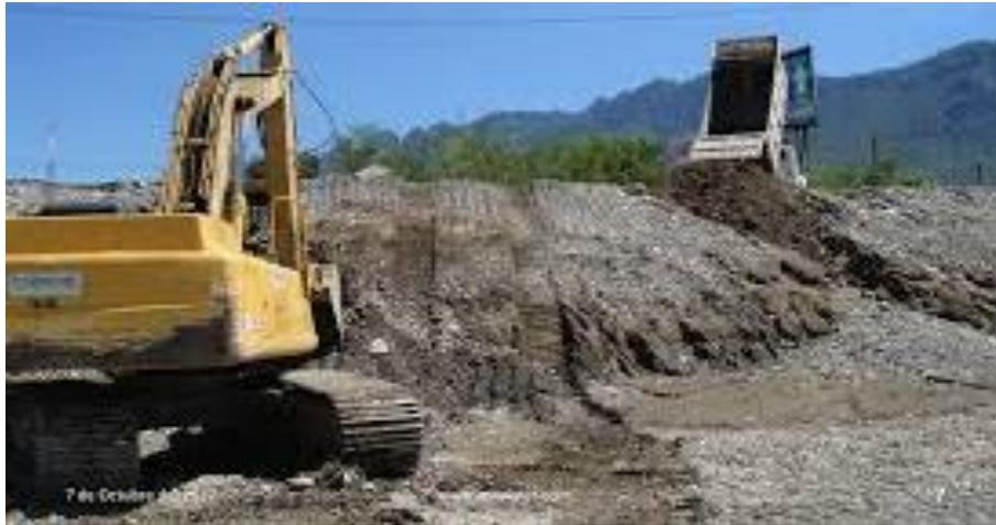
**Ilustración 1.** Relleno a volteo.
