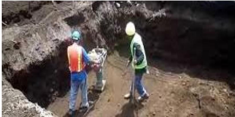
**Ilustración 2.** Relleno compactado
