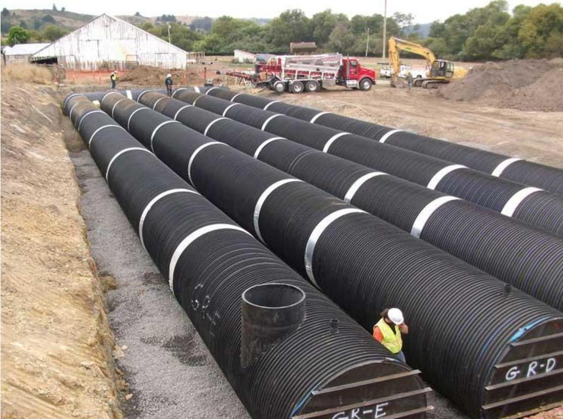
Figura 11: Cisternas usadas para almacenamiento de Aguas Lluvias. JVP Consultores. (2016). Manual de Drenaje Pluvial Urbano de la Ciudad de Guayaquil.
