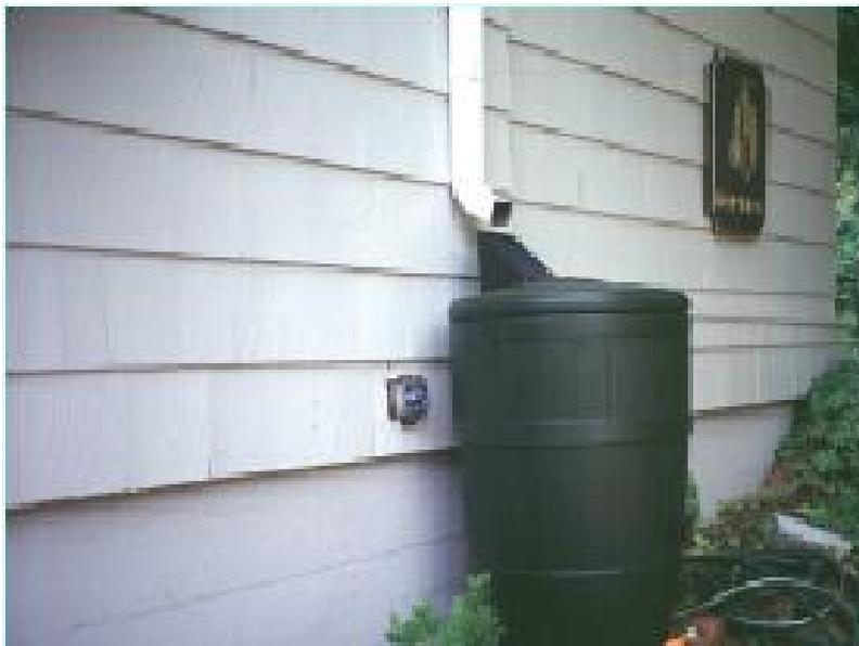
Figura 6: Tanque reservorio de Aguas Lluvias provenientes de los techos. JVP Consultores. (2016). Manual de Drenaje Pluvial Urbano de la Ciudad de Guayaquil.
