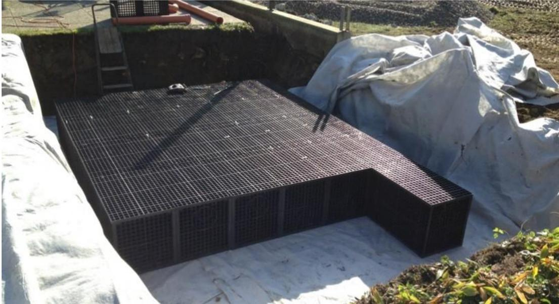
Figura 10: Reservorio de Detención usando sistemas modulares geocelulares.
