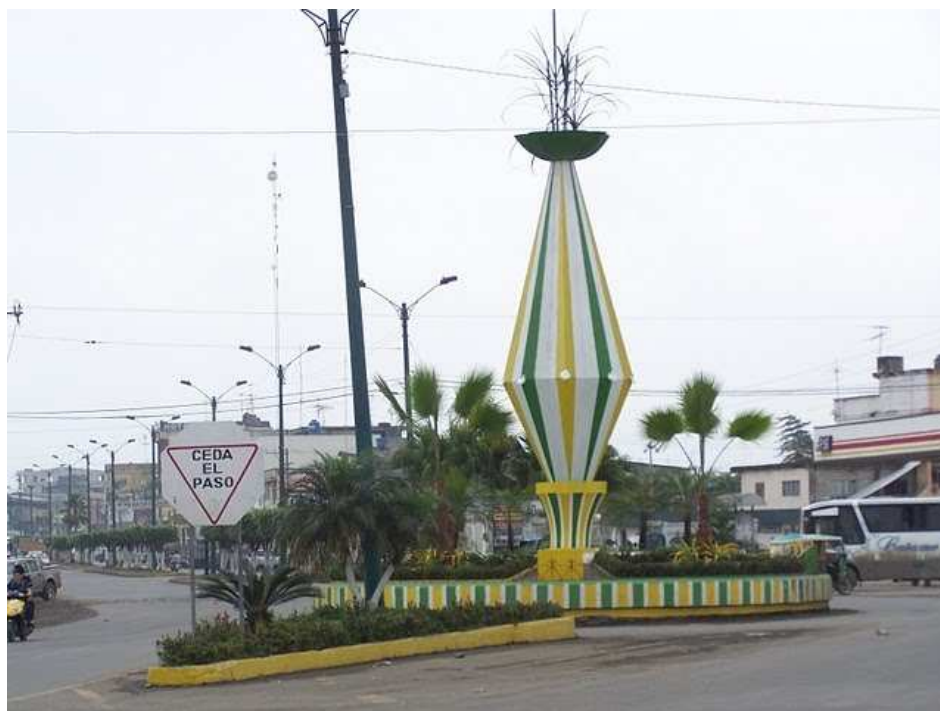
Gráfico 11. Carretera Duran – Tambo. (Acceso La Troncal)
