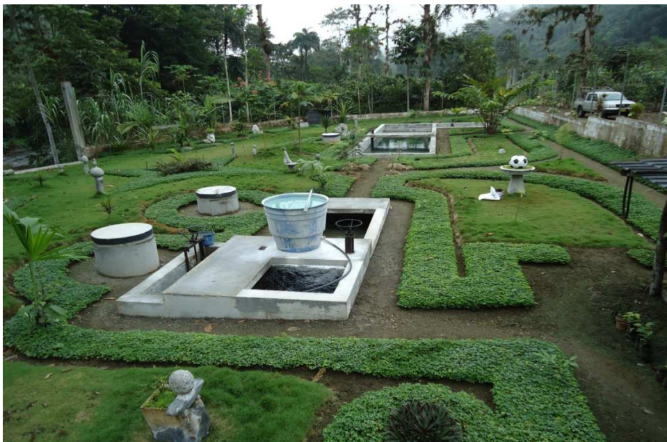
Gráfico 14. Infraestructura Captación Yanayacu
