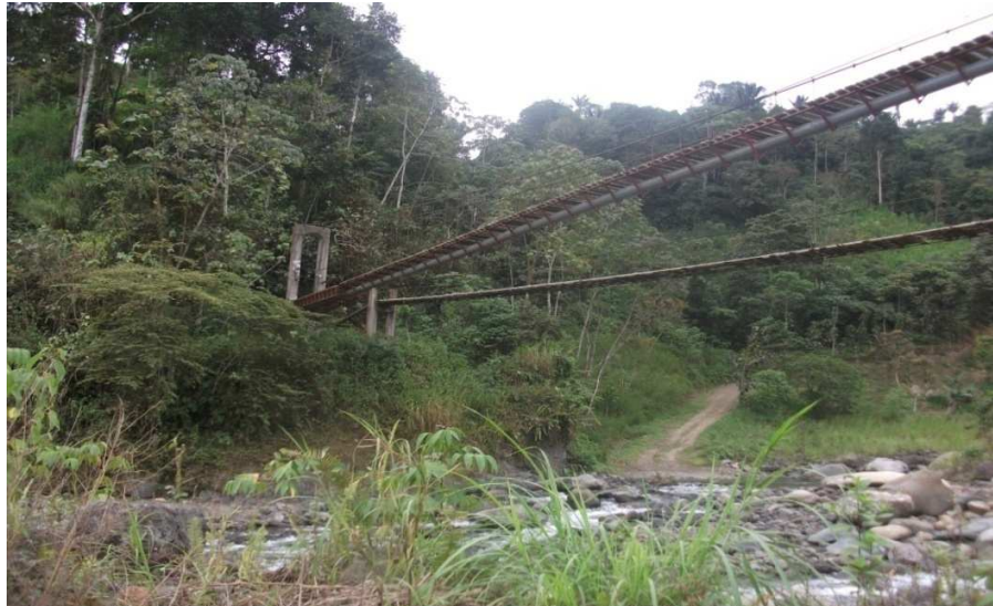
Gráfico 15. Conducción de Agua cruda – Paso elevado Rio Bulu Bulu sector Palillos
