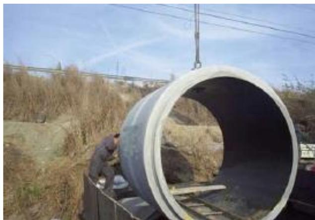
***Figura 43: Con orificio de maniobra***
