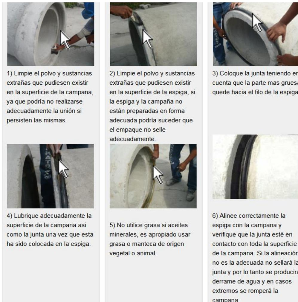
**Figura 45: Colocación de la junta Neopreno 1**
