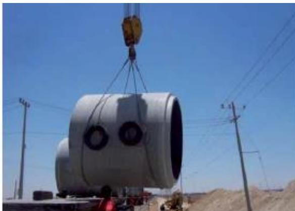
*Figura 44: Estrobo de acero (utilizado en el actual proyecto de estudio)*
