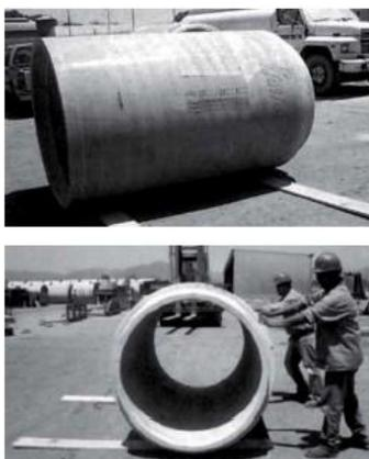
**Figura 36: Rodamiento de tubería**
