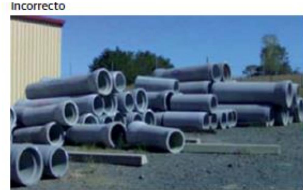
*Figura 38: Incorrecta estiba de tubería de hormigón*
