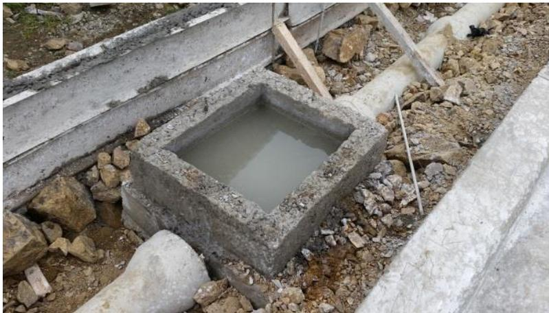
*Figura 18: Caja de registro para tubería de hormigón  $\varnothing$  250 mm
