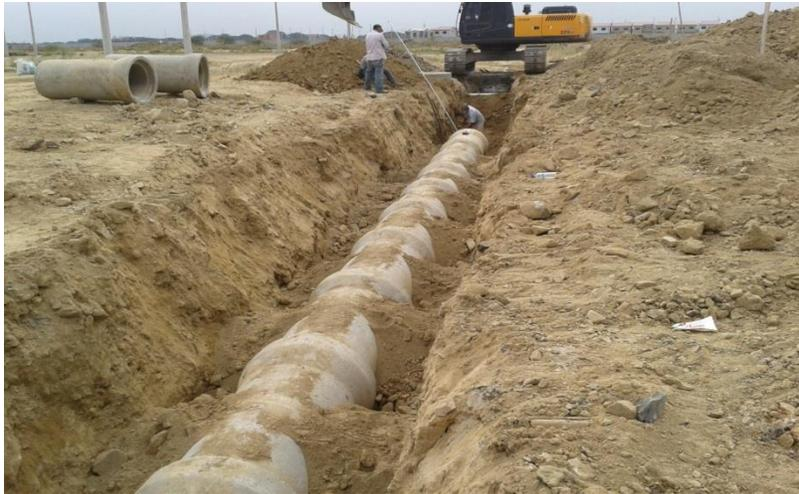
*Figura 17: Colector secundario con Tubería de hormigón  $\varnothing$  750 mm
