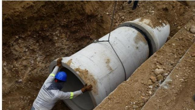
*Figura 19: Colector Principal con tubería de hormigón Ø 1200 mm*
