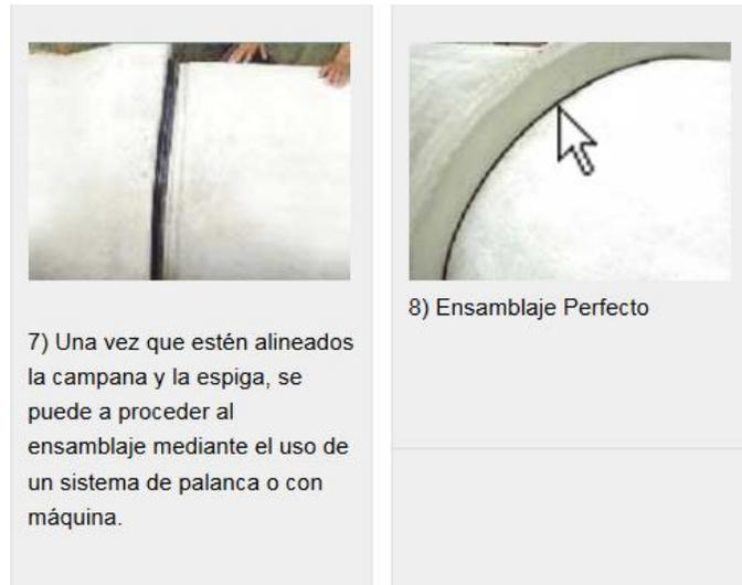
**Figura 46: Colocación de la junta 1**
