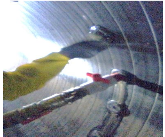
Imagen 27: Conexión de las mangueras a la llave para inyectar el mortero fluido
