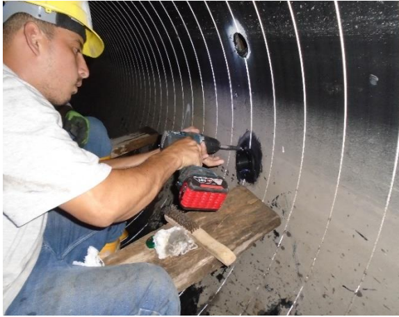
Imagen 24: Proceso de perforación e instalación de las boquillas en la tubería nueva
