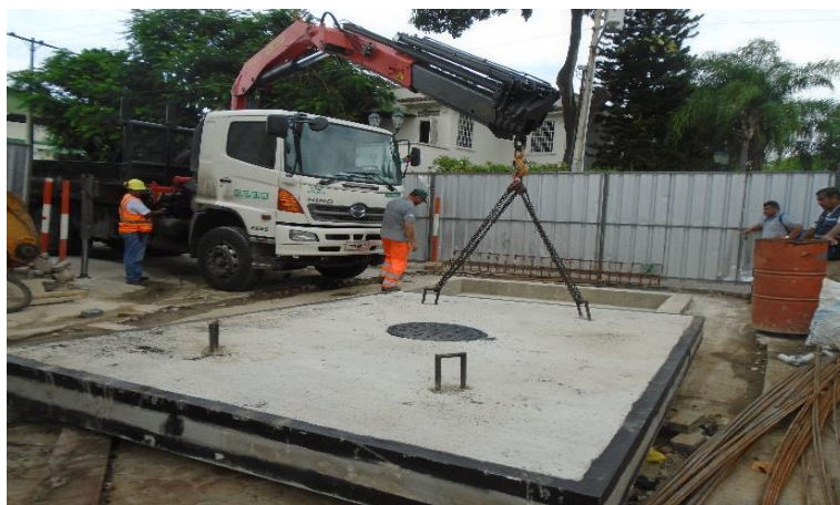
Imagen 11: Instalación de la tapa losa desmontable sobre la cámara N° 7
