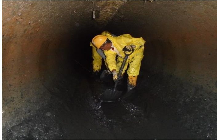
Imagen 16: Limpieza manual del tramo 8-9 desde la cámara N° 9
