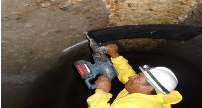
Imagen 19: Instalación de placas dentro del tramo entre las cámaras N° 9 y 10
