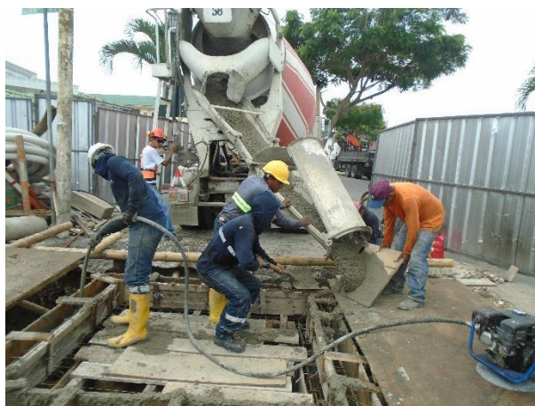
Imagen 8: Hormigonado de los muros de la cámara N° 8
