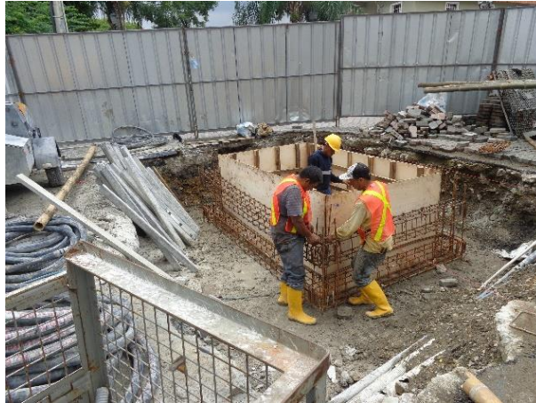
Imagen 7: Armadura de hierro y encofrado de la cámara N° 7
