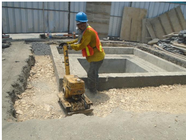
Imagen 10: Compactación alrededor de la cámara N° 11
