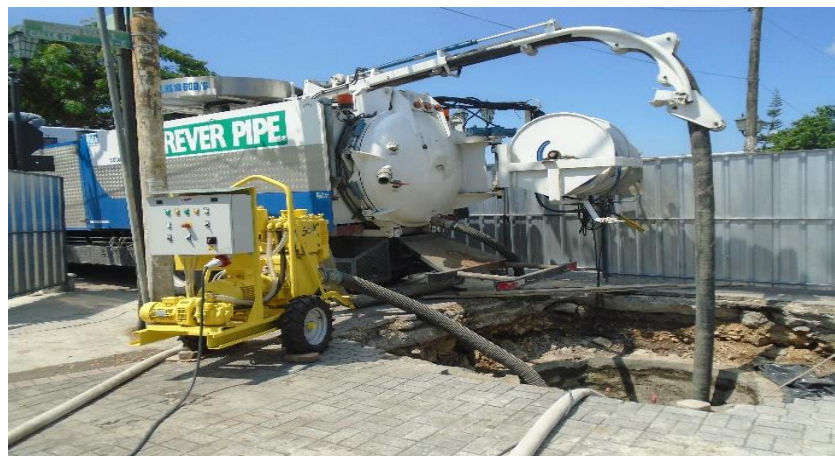
Imagen 15: Limpieza con el camión desobstructor del tramo 8-9 desde la cámara N°9
