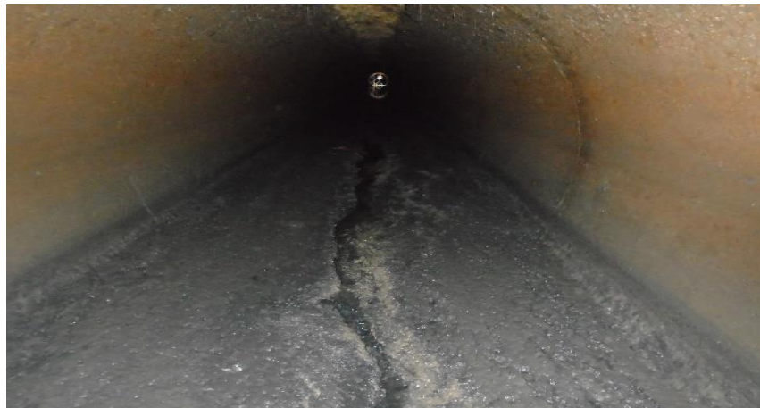
Imagen 14: Lodos presentes dentro de la tubería del tramo entre las cámaras N° 8 y N° 9
