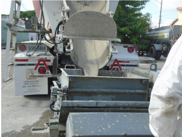
Imagen 26: Descarga del mortero fluido desde el mixer hasta la máquina de bombeo
