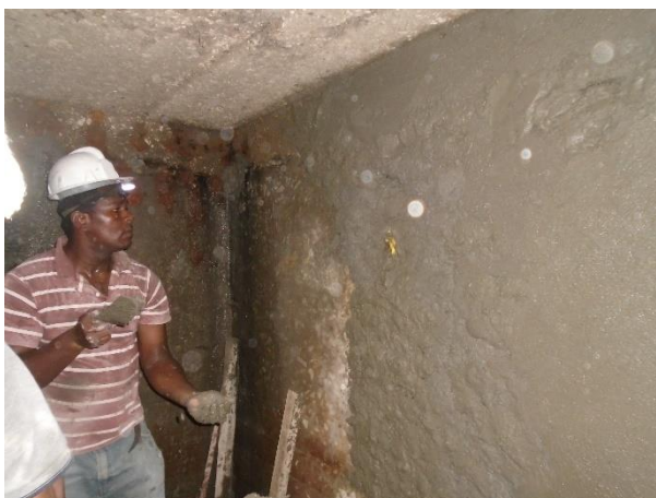
Imagen 13: Enlucido de las paredes de la cámara N° 14
