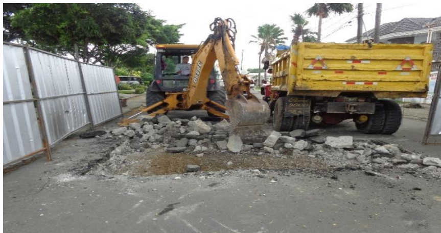
Imagen 5: Excavación y desalojo de la cámara N°16
