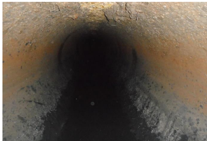
Imagen 17: Tramo 8-9 después de la limpieza
