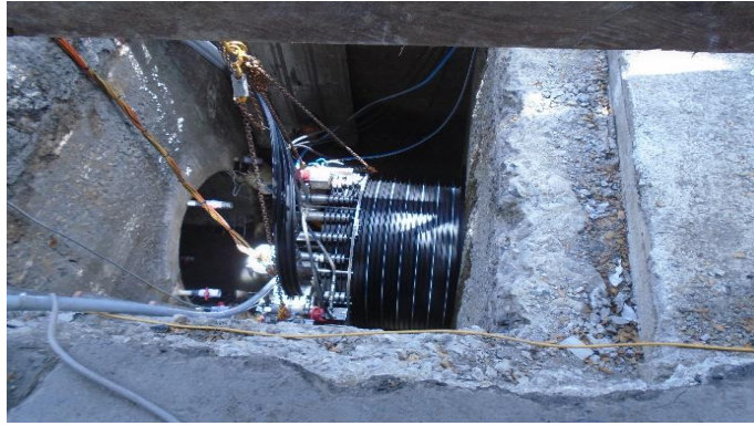
Imagen 21: Formación de la tubería nueva dentro del tramo 16-17
