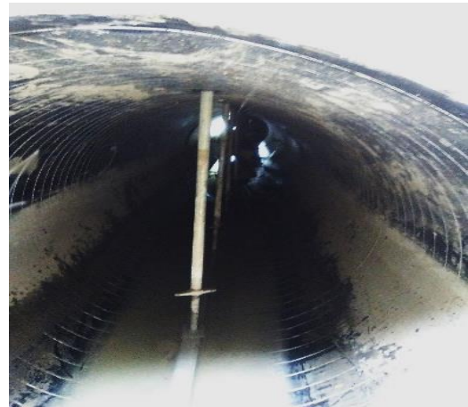
Imagen 25: Apuntalamiento de la tubería nueva para poder realizar la inyección de mortero.
