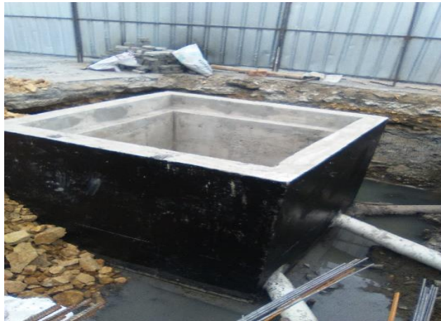
Imagen 9: Impermeabilización de los muros de la cámara N° 8
