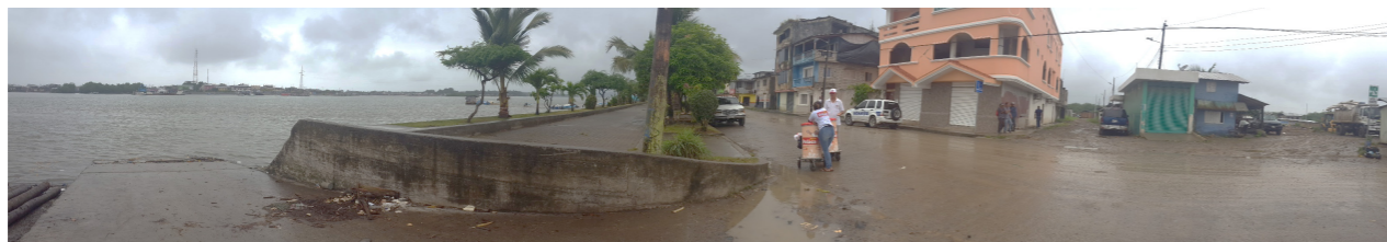
Fig. 7, ACCESO AL MUELLE Y CALLE PRINCIPAL CON INGRESO AL TERRENO, MUISNE Autora: Janise Vivar (2016)
