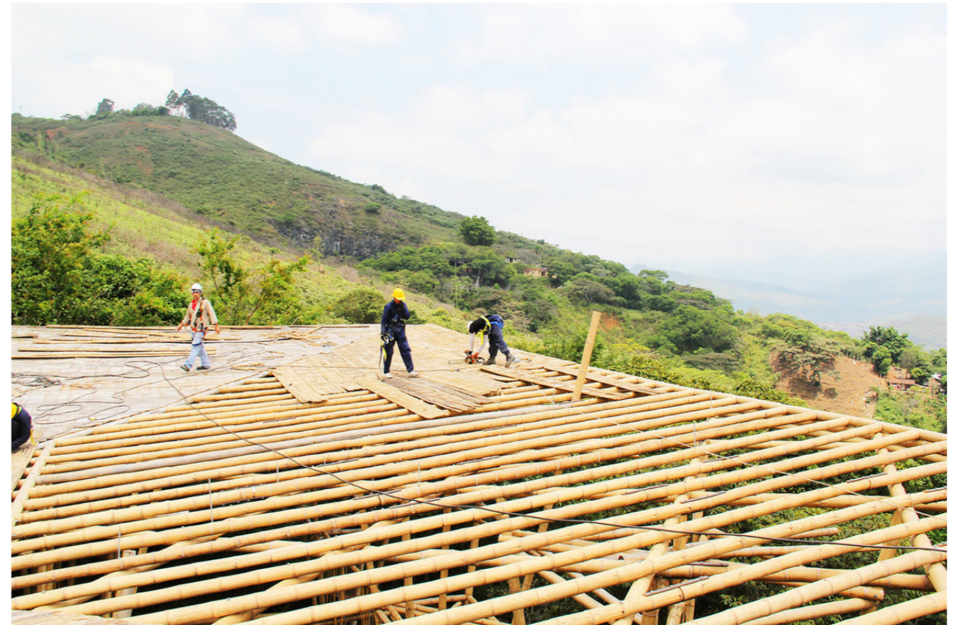
Foto 12: Estructura de cubierta con caña guadúa. Autor: Báppler, A. (2014)
