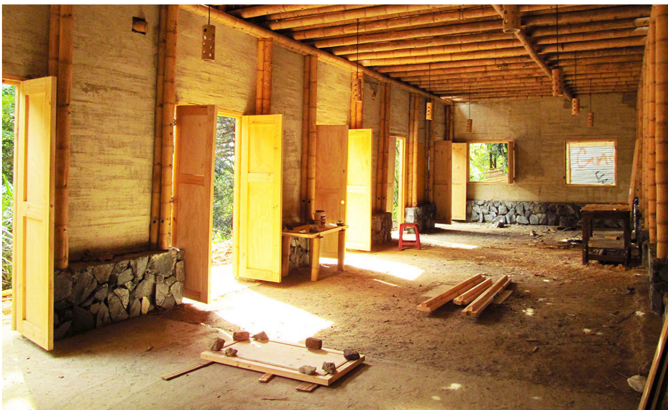
Foto 13: Muros de bahareque terminados en aulas. Autor: Báppler, A. (2014)
