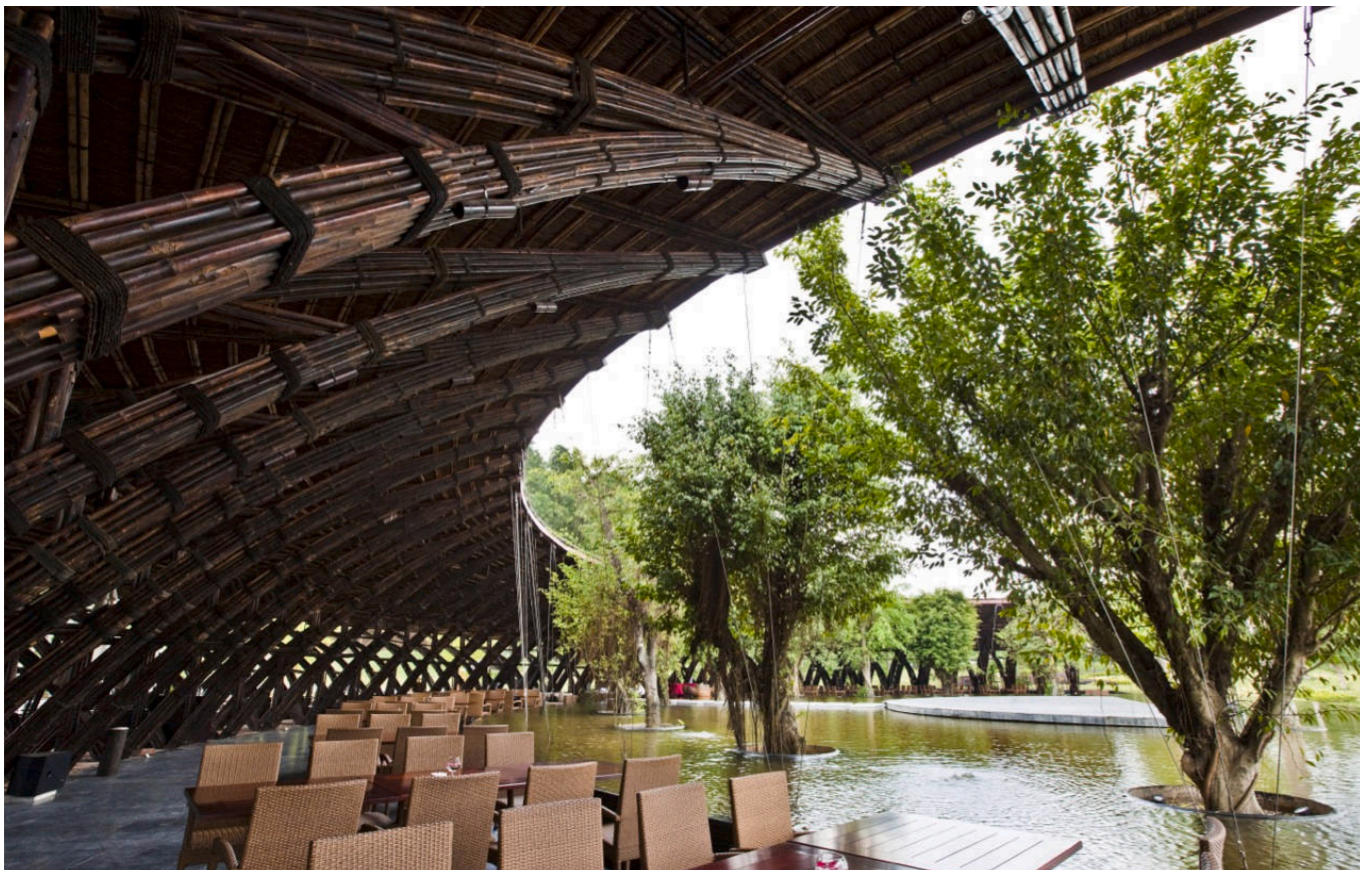
Foto 9: Volado de 8m con vigas de bambú con abrazaderas en Vietnam. Autor: Hiroyuki, O. (2010)
