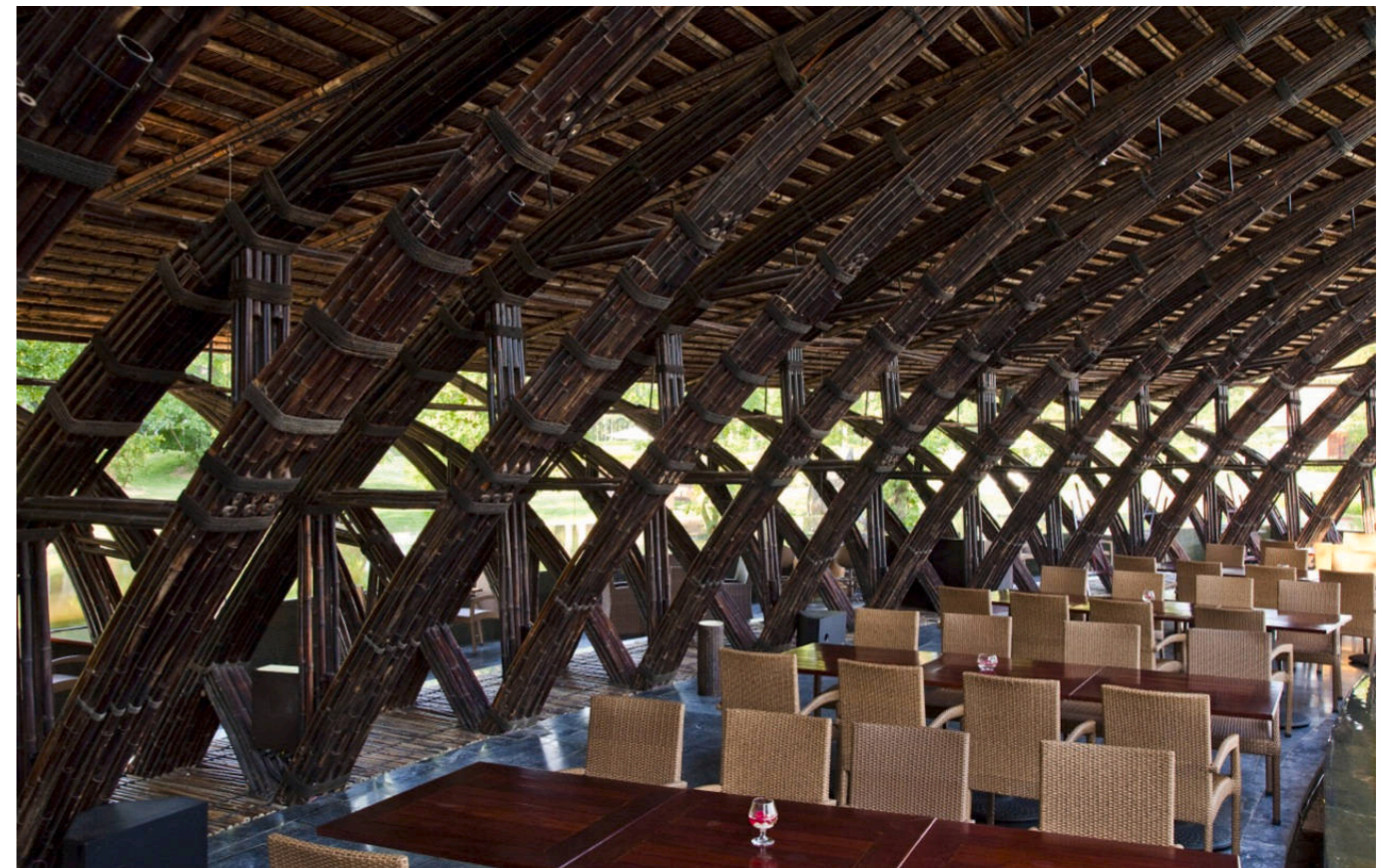
Foto 10: Sucesión de columnas de bambú con tensores. Autor: Hiroyuki, O. (2010)
