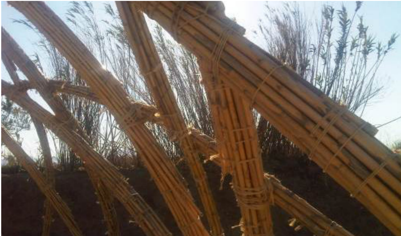
Foto 4: Método constructivo de cubierta con cañas curvas amarradas. Autor: Baron, C. (2014)
