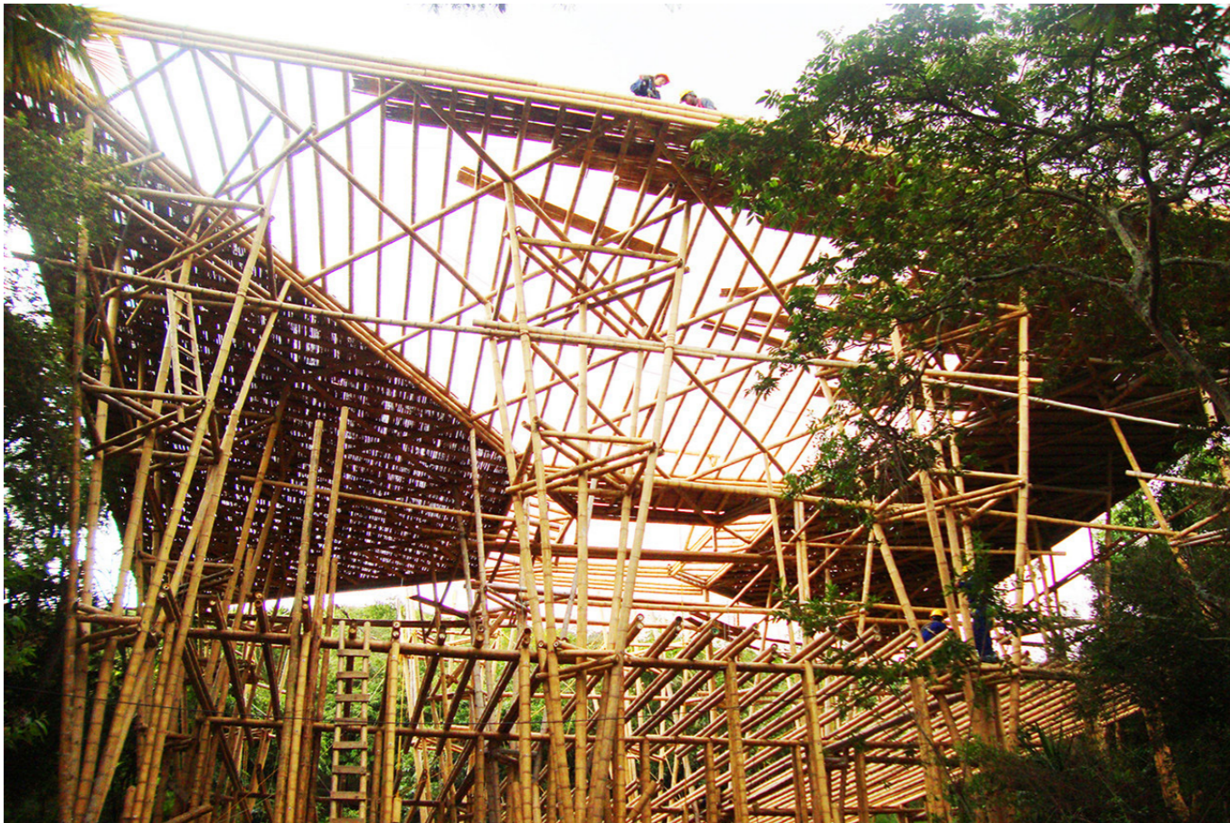
Foto 11: Estructura de caña del Colegio de las Aguas de Montebello en Cali, Colombia. Autor: Báppler, A. (2014)
