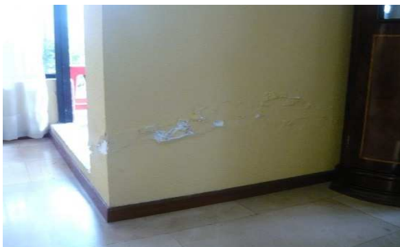
Figura 2. Revestimientos afectados
