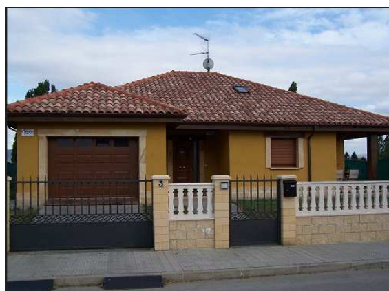
Figura 16. Vista de fachada en construcción de 70 m 2
