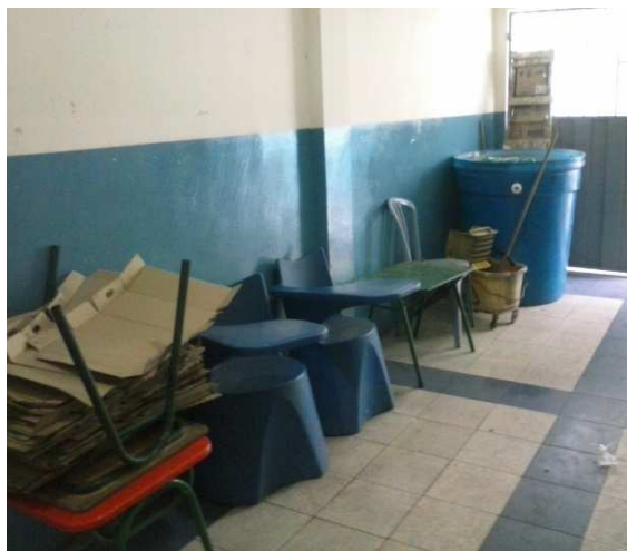
Figura 16: corredor baterías sanitarias Fuente: elaboración propia
