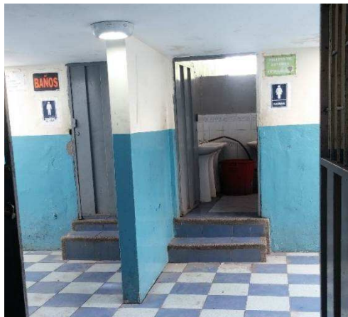
Figura 6: ingreso baterías sanitarias Fuente: elaboración propia
