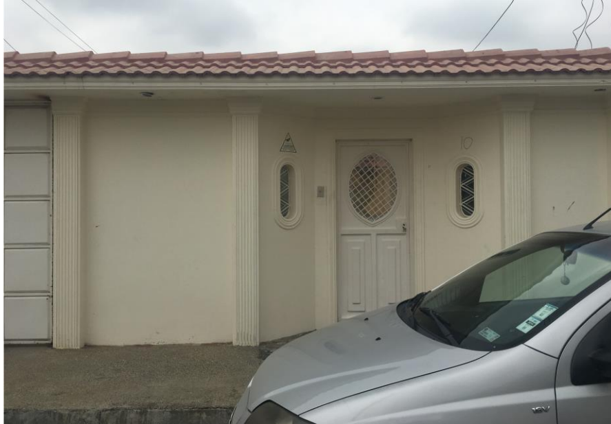
Figura 4-5: Fachada de la empresa
