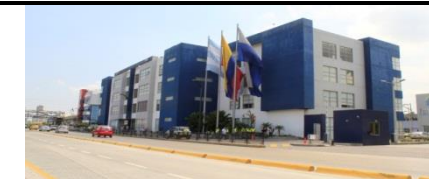
Figura 19: UVCM.- fachada Fuente: elaboración propia (2015)
