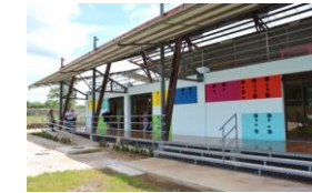
Figura 18: Centro de Cuidado y Desarrollo Infantil de Nicoya Fuente: Los del desierto. Plataforma Arquitectura. (2015)
