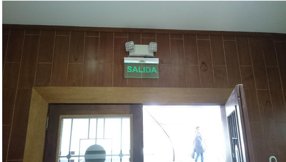
Figura 30. Luces y señalética de emergencia
