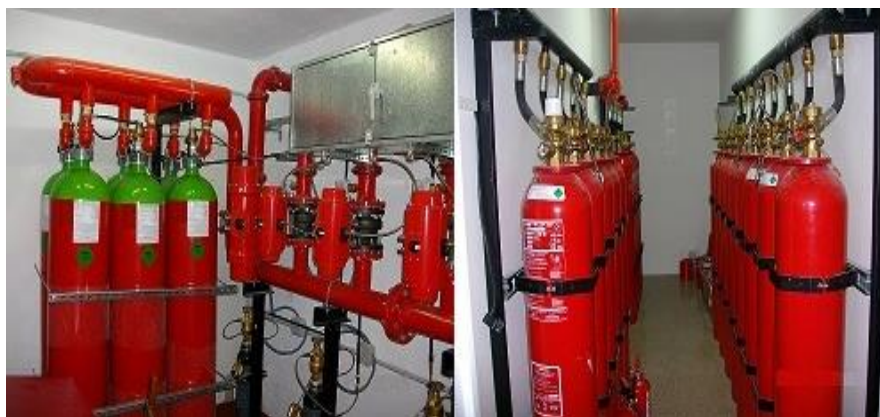
Figura 2.21: Sistema fijo de gas Fuente: Bleye Vicario (2012)
