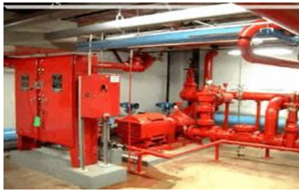
Figura 2.24: Sistema fijo de agua Fuente: Bleye Vicario (2012)
