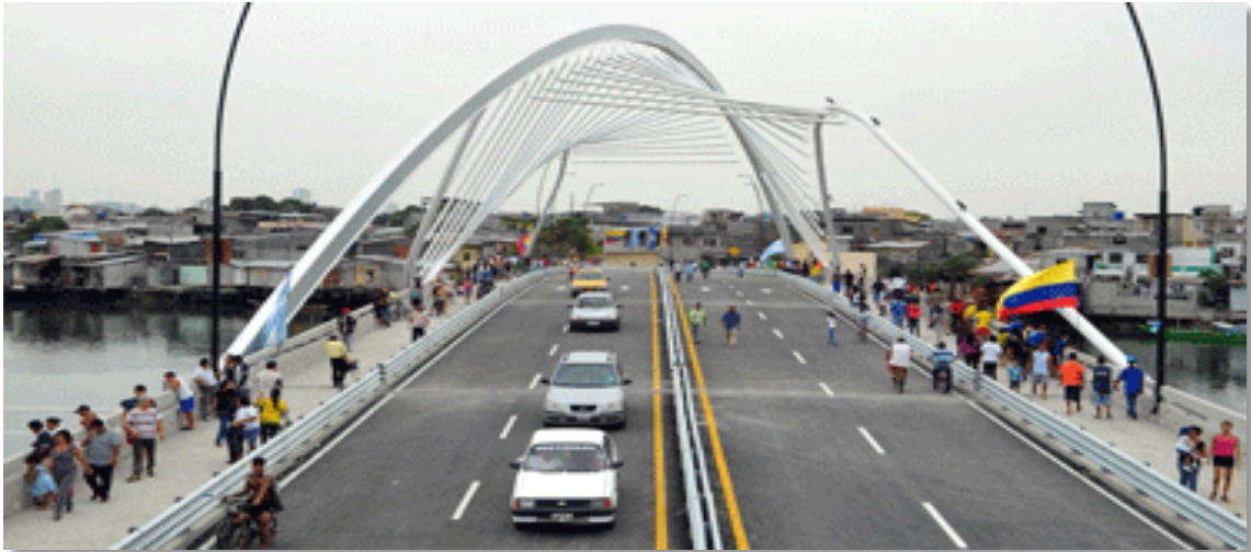
Figura 50. Puente de la Calle A, Guayaquil.
