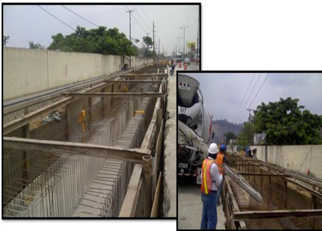
Figura 31. Canal Interagua Sector Puente Portete- PJ.
