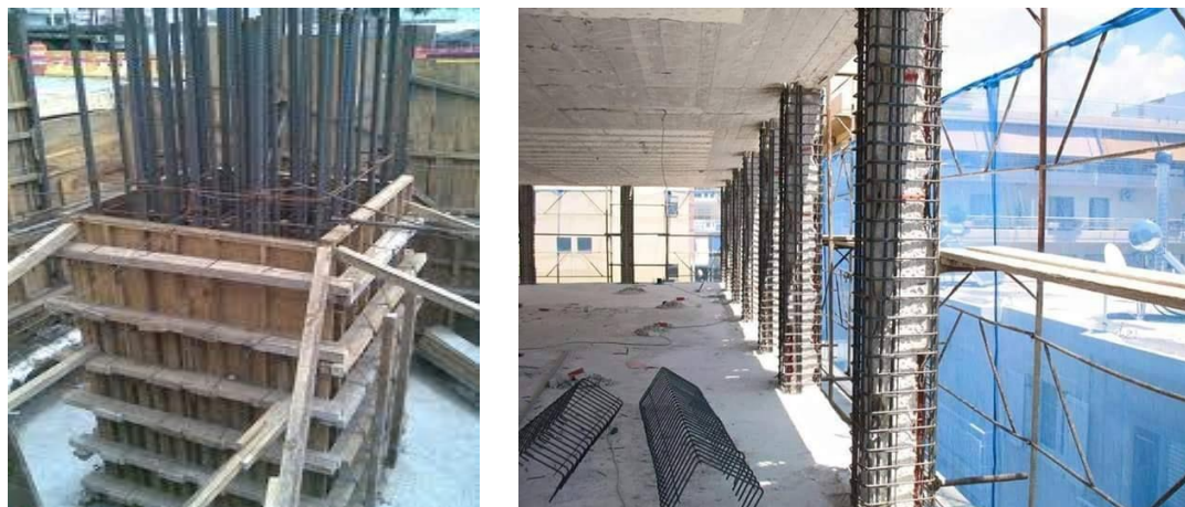
Figura 40. Armado típico de una columna.
