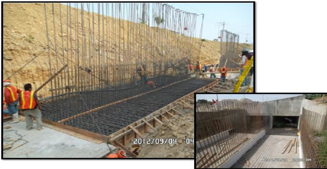
Figura 32. Muro de Contención- Ducto Cajón Casuarina.
