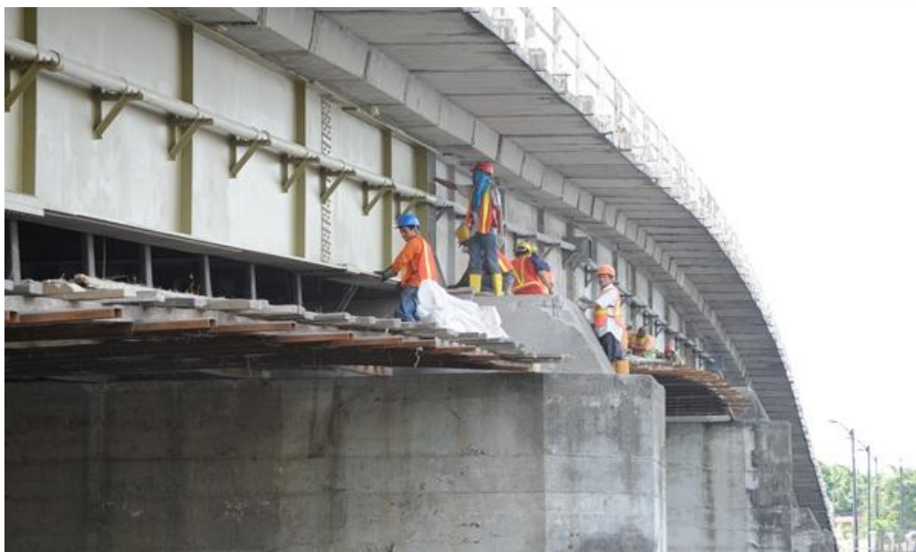
Figura 49. Reparación del Puente de la Calle Portete.
