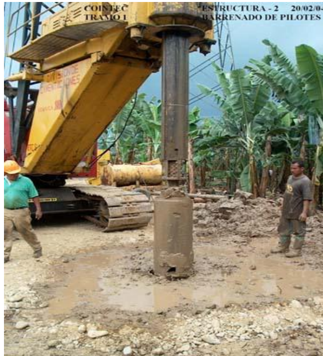
Figura 10. Barrenado de Pilotes
