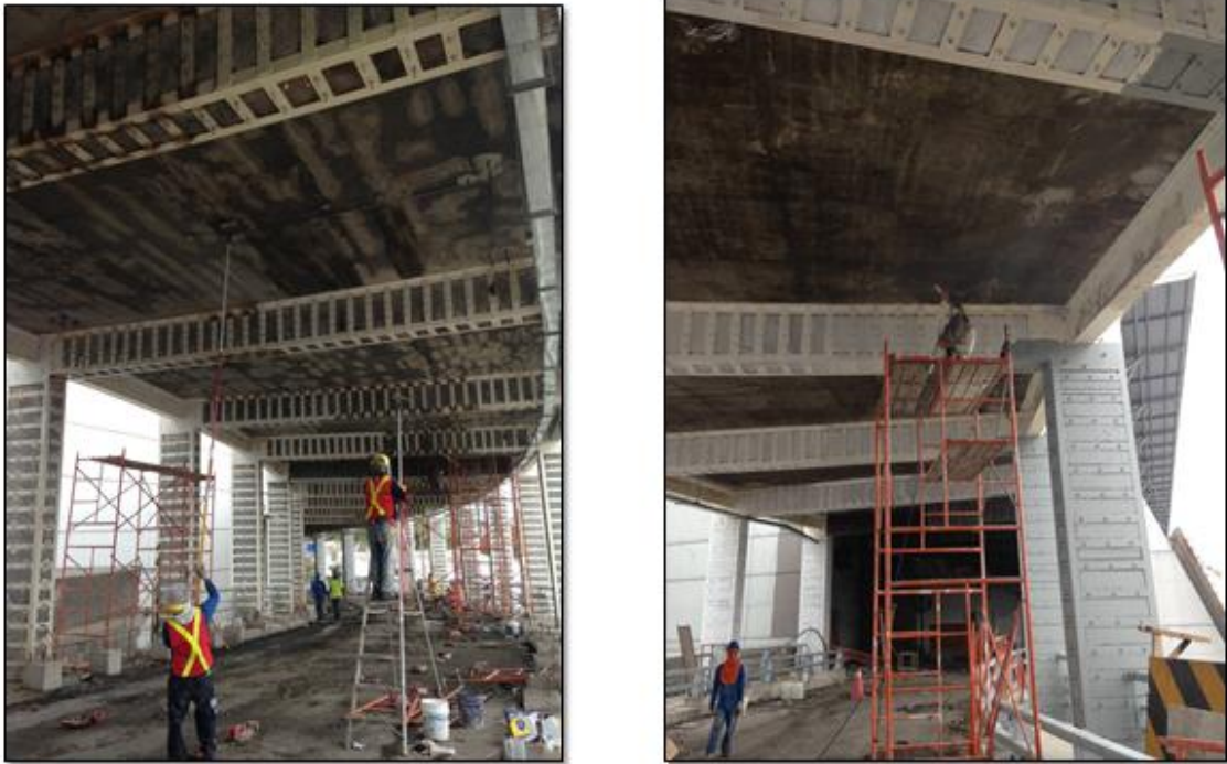
Figura 28. Protección de Rampas del Terminal Terrestre de Guayaquil.
