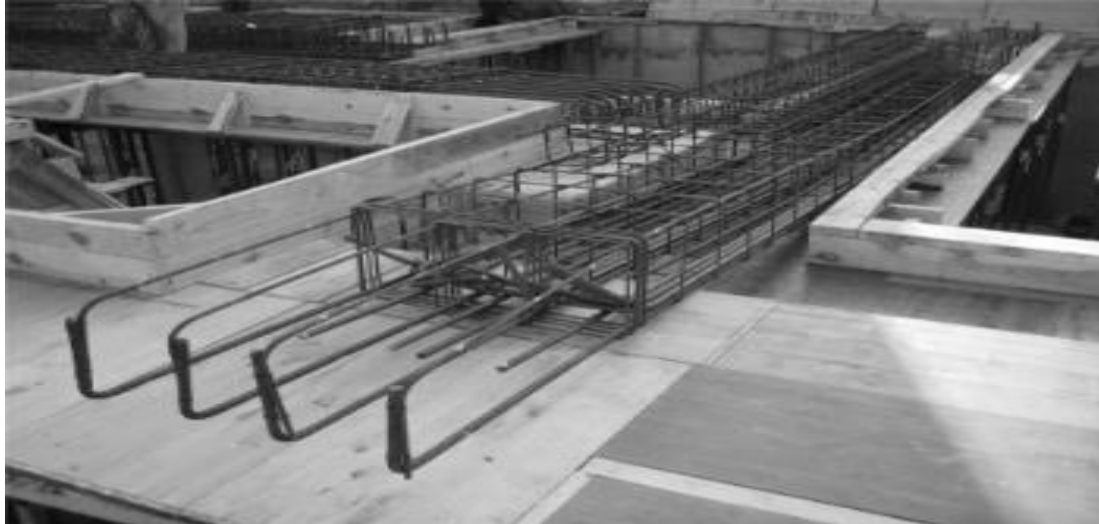
Figura 42. Armaduras de vigas preparadas para colocar en el encofrado.
