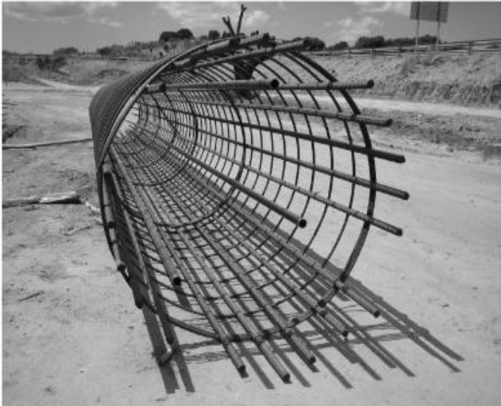
Figura 36. Armadura de un Pilote.
