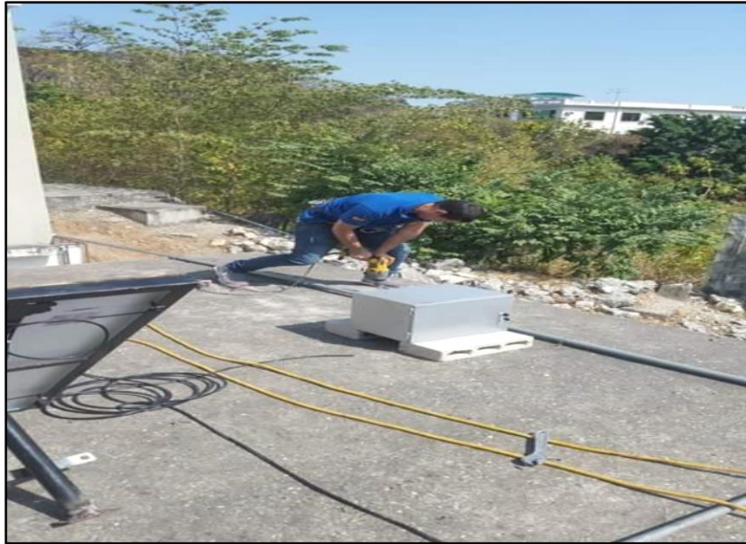
Imagen 7.1: Perforación donde va fijada base del módulo fotovoltaico
