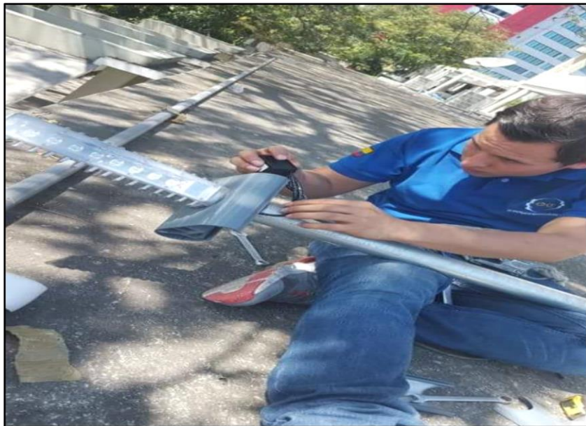
Imagen 7.4: Conexión de la Lámpara LED
