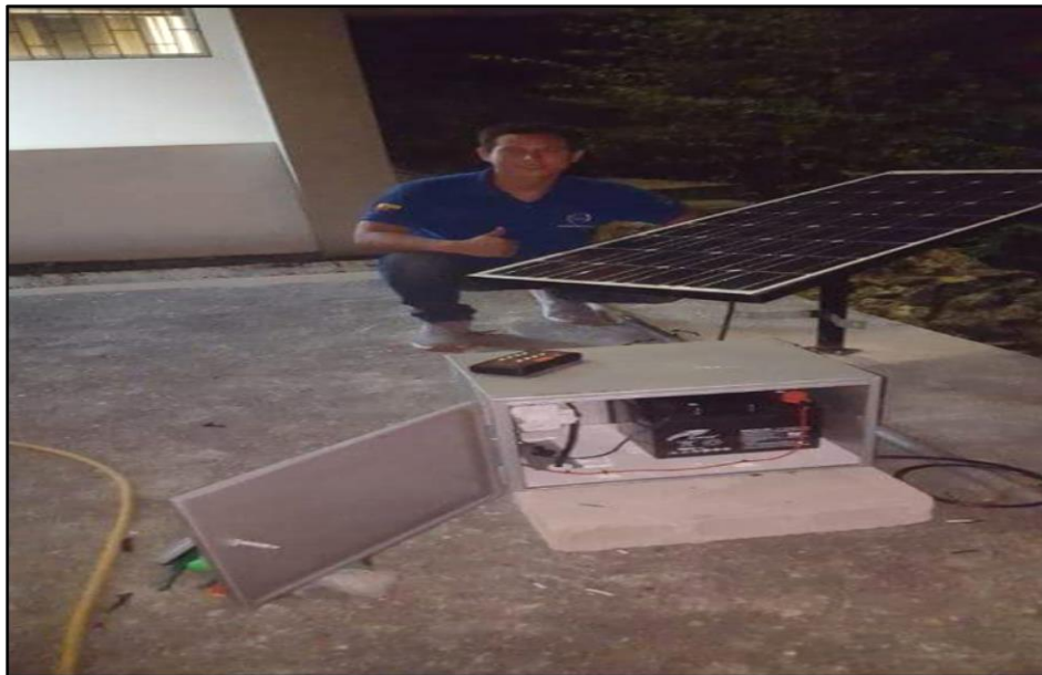
Imagen 8.4: Prueba de funcionamiento del sistema de iluminación fotovoltaico
