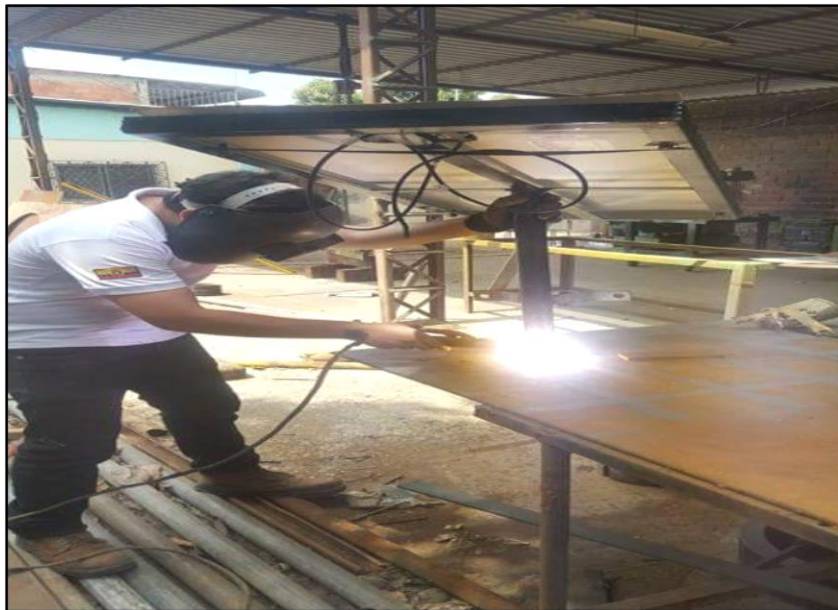
Imagen 6.2: Soldado de base para modulo fotovoltaico
