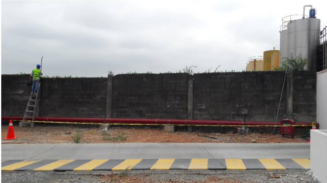
Figura 3. 19: Delimitación del área de trabajo en soldadura eléctrica. Fuente: Fotografía tomada en visita técnica.
