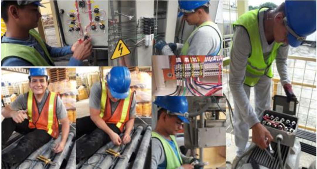
Figura 3. 14: Trabajos de mantenimiento en planta y código de colores correcto. Fuente: Fotografías tomadas visita técnica.
