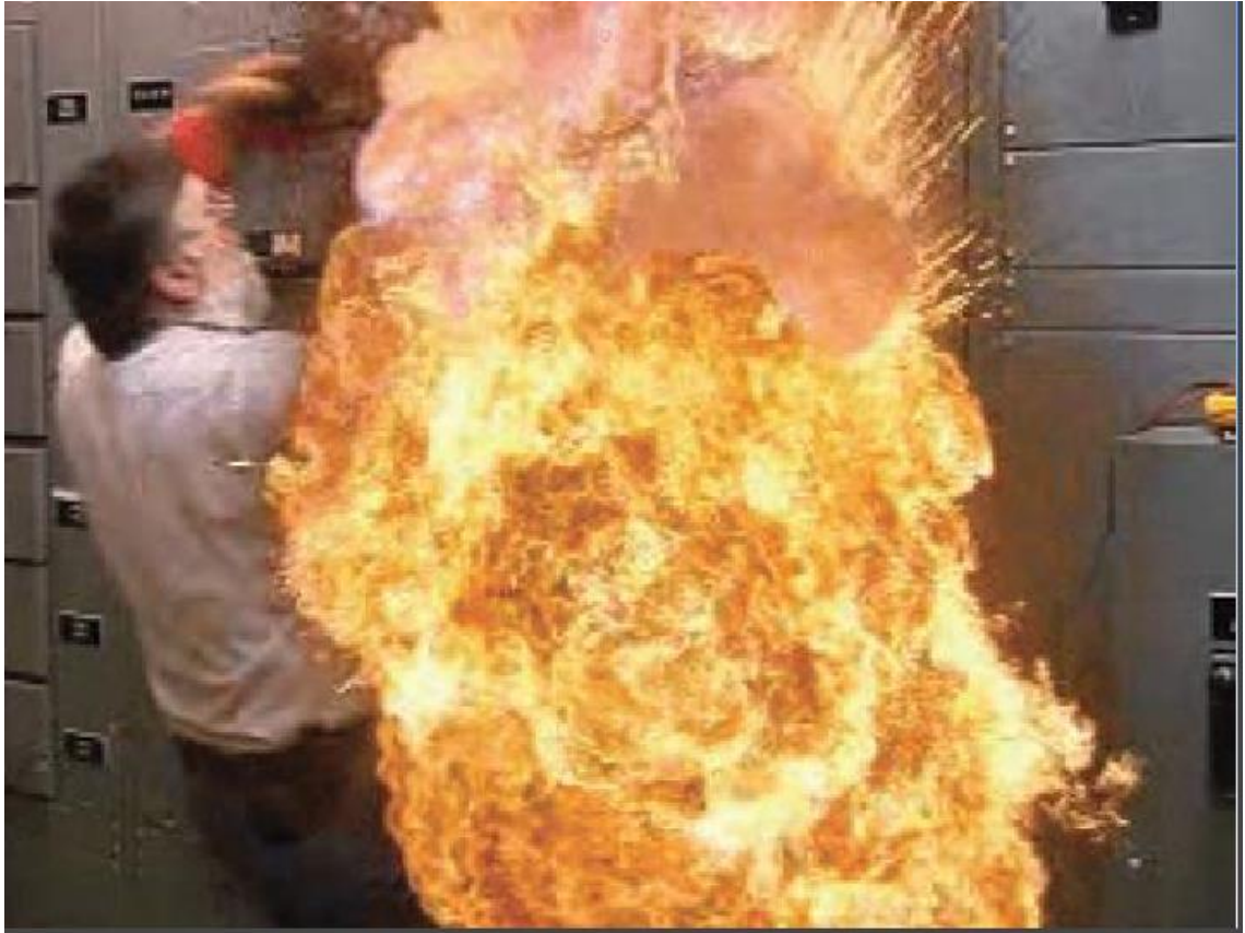
Figura 2. 5: Explosión producida por arco eléctrico. Fuente: (Dr. Eduardo Andrade Terán, 2014)
