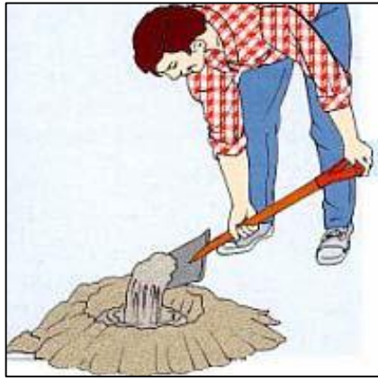
Gráfico 22: Preparación de la mezcla en obra de suelo cemento fluido u hormigón pobre
