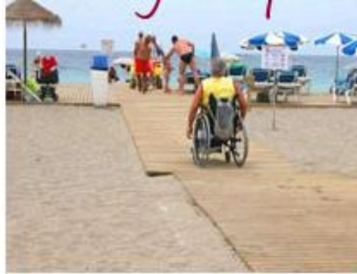
Figura 15: Caminera de madera en playa de Islas Canarias. Fuente: barrera-cero.com. 2016.
