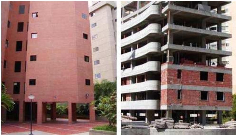
Figura #44. El edificio a la izquierda es un edificio de mediana altura relativamente nuevo. El edificio a la derecha es un edificio de mediana altura en construcción. Ambos tienen la típica Planta Baja, que crea pisos blandos y débiles. (Fierro, 2004)
