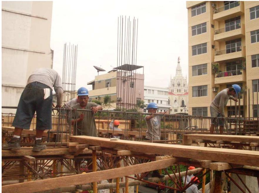
Estructuración de acero de vigas de hormigón armado
