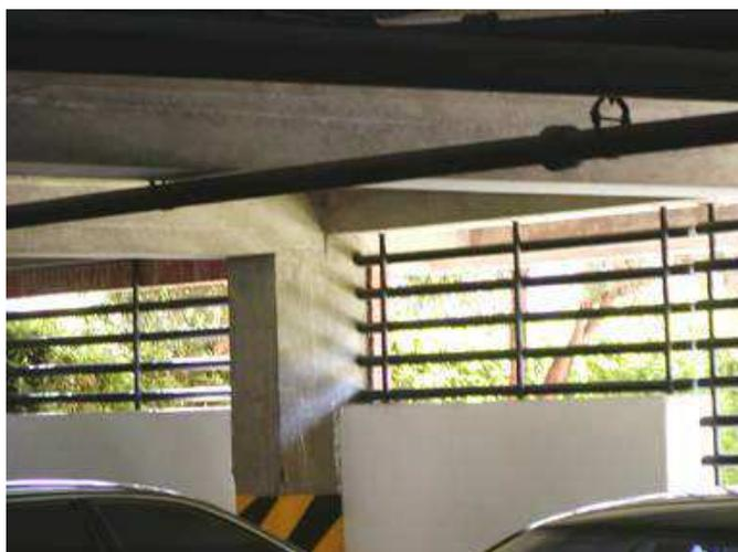
Fig. #58. Columna corta causada por albañilería. (Civilgeeks,
