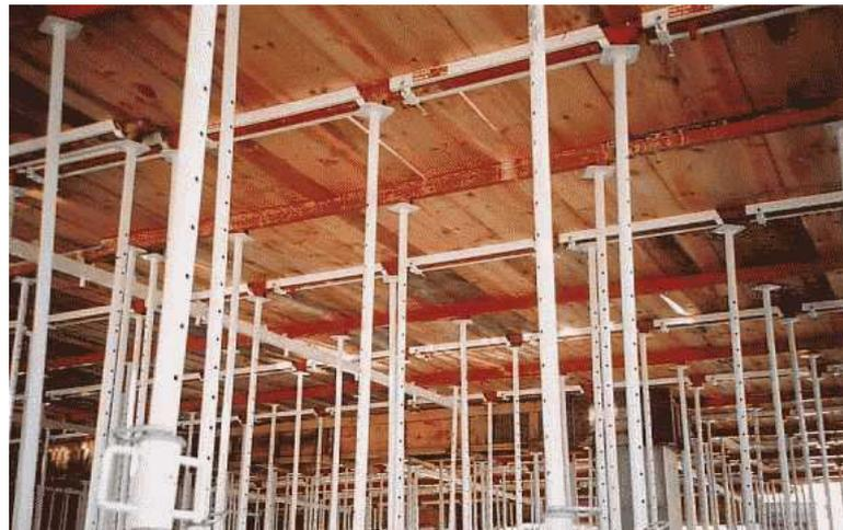
Fig. #35 Losa apoyada en madera (Construyendo, 2013)
