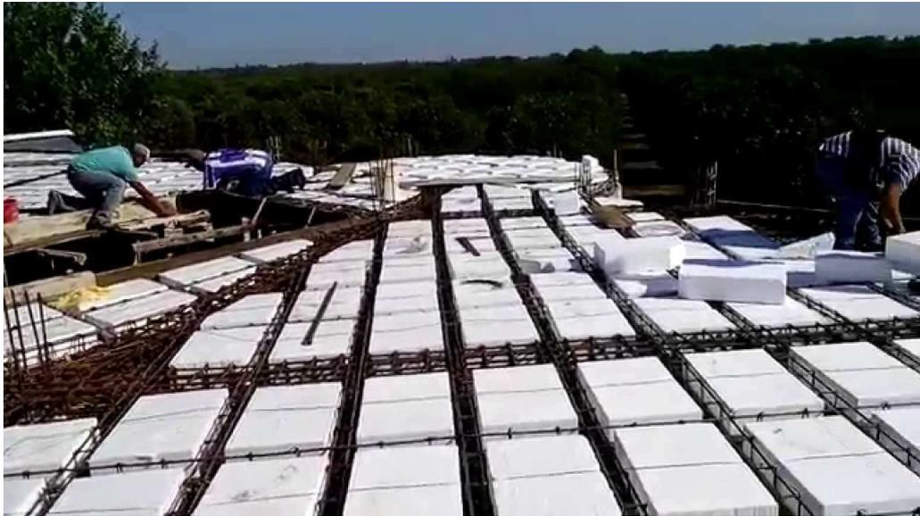
Estructuración de viguetas de losa nervada (Construyendo, 2013)
