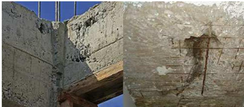
Fig. #54. Consecuencias de la falta de vibrado al momento de fundir el elemento estructural. (Esteban, 2015)
