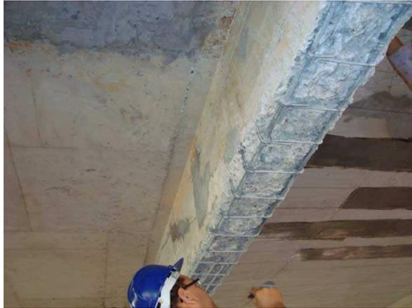
Fig. #48. Falta de recubrimiento en viga (Diez, 2012)
