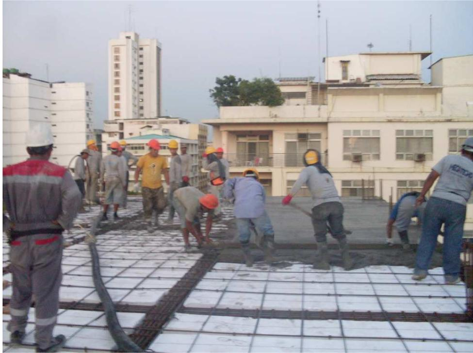
Fundición de losa de hormigón armado
