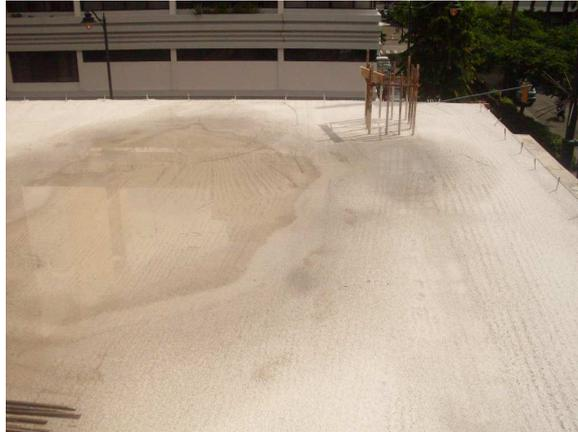
Fotografía #9. Filtración en losa por falla de pendientes.
