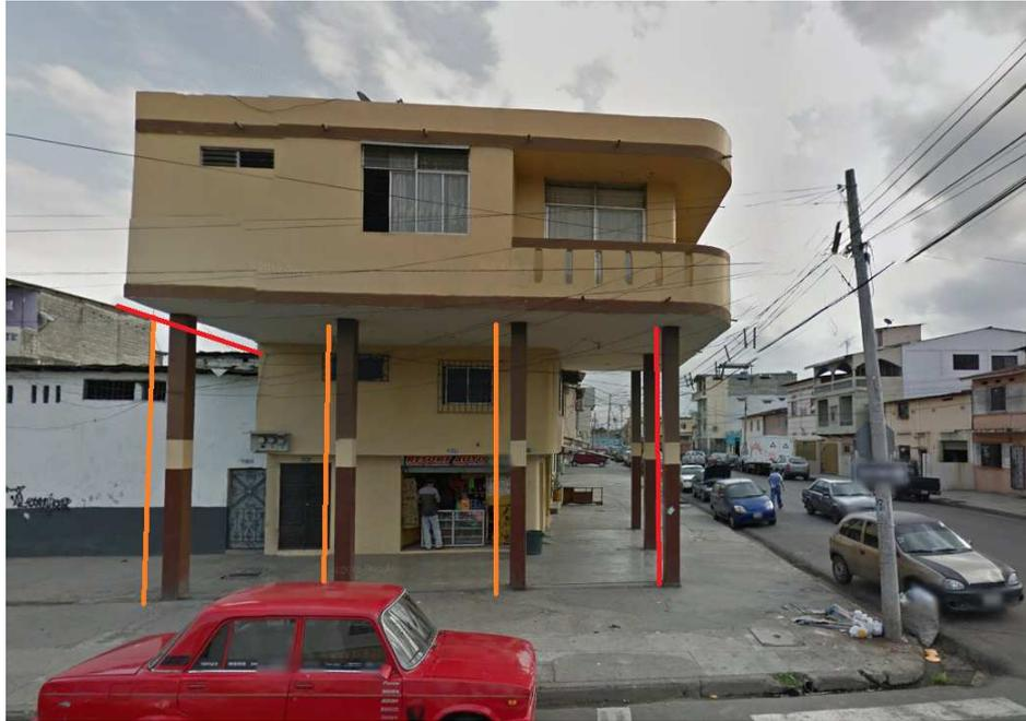
Fotografía #4. Edificio con asimetrías en planta baja en Ayacucho y
