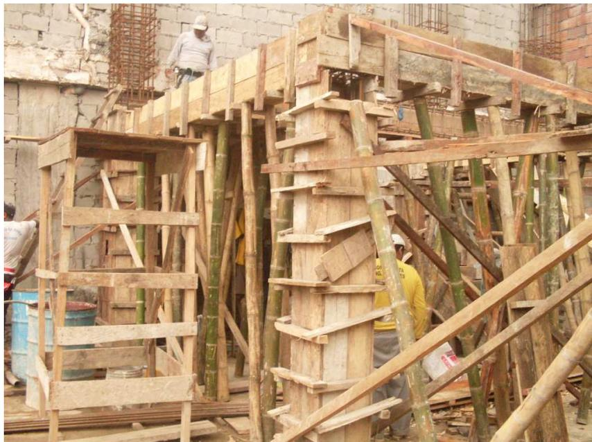
Empleo de encofrado de columnas y vigas.
