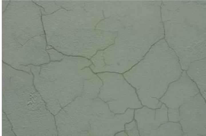
Fig. #57. Fisuras de losa por mal curado de la misma.
