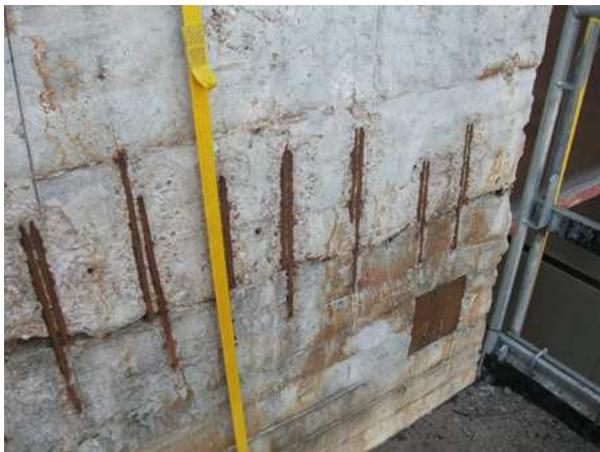
Fig. #49. Falta de recubrimiento en columna (Diez, 2012)
