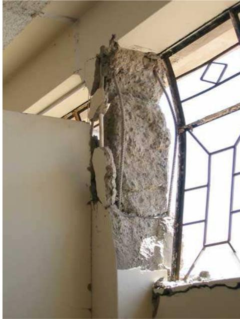
Fig. #52. El deficiente dimensionamiento, falta de estribos y la mala calidad del concreto hicieron que la columna falle.
