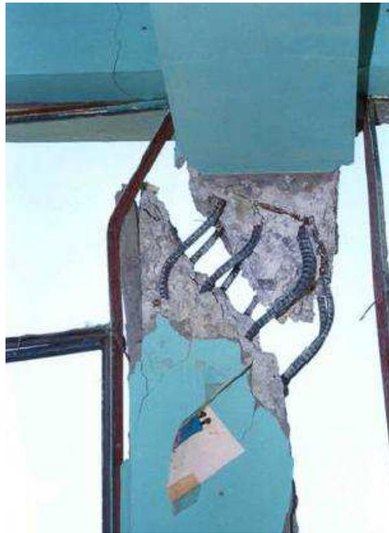
Fig. #51. Colapso de columnas por falta de estribo (Civilgeeks, 2011)
