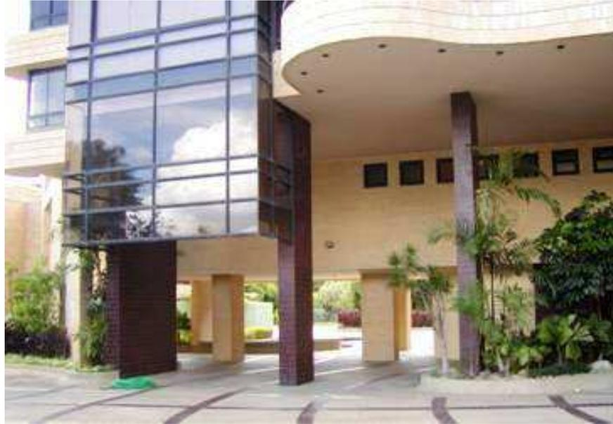
Figura #45. Típica Planta Baja con un primer piso alto y con las columnas que varían significativamente en altura. (Fierro, 2004)
