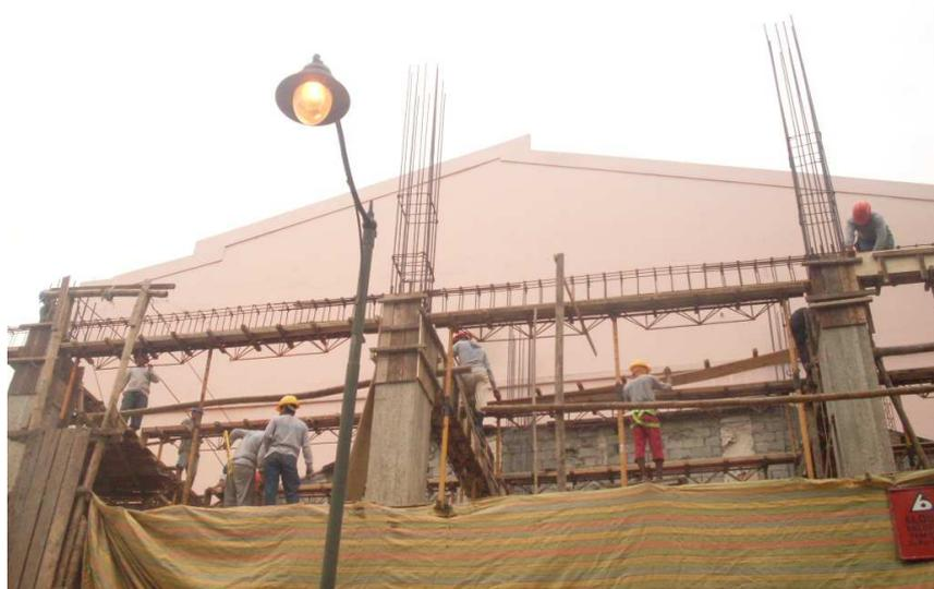
Desencofrado de elementos anteriormente fundidos y preparación de vigas y columnas de siguiente nivel.
