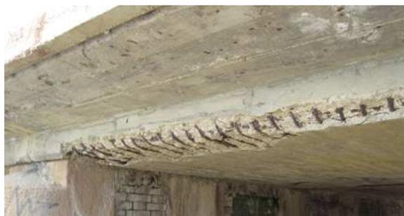
Fig. #47. Falta de recubrimiento en losa (Diez, 2012)
