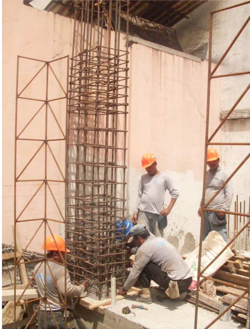
Configuración de armadura mediante la colocación de refuerzos longitudinales y transversales [Fotografía de Arq. Aicardo Zuluaga].(Guayaquil.2012) Archivos fotográficos de Edificio XAMI COLLECTION. Sucre y Chile
