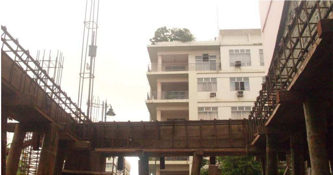
Estructuración de acero de vigas de hormigón armado.
