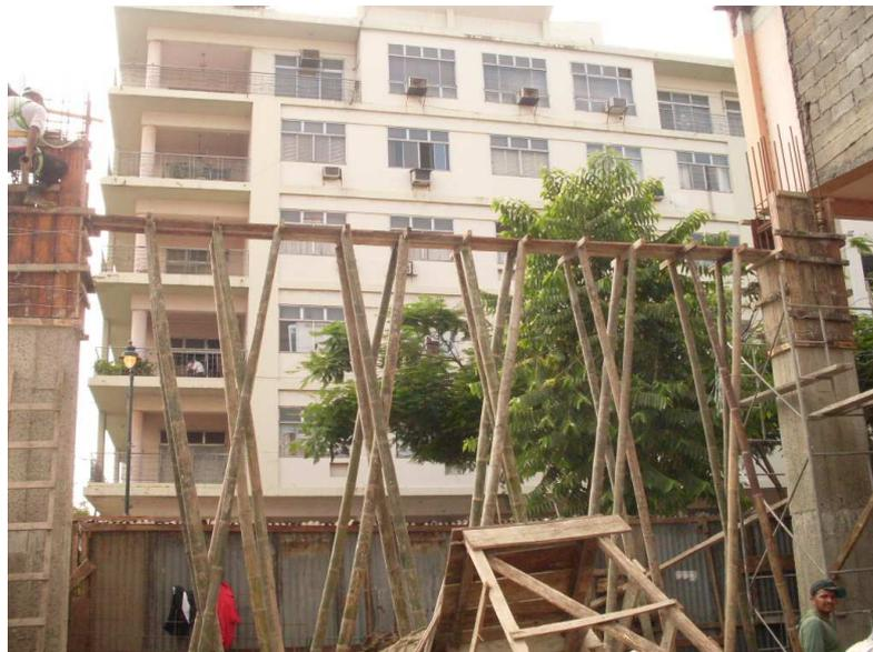
Instalación de estructuras de soporte previo con cañas
