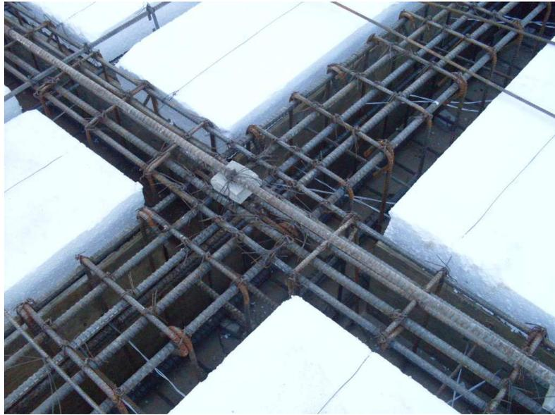
Colocación de separadores de hormigón según la necesidad del recubrimiento.
