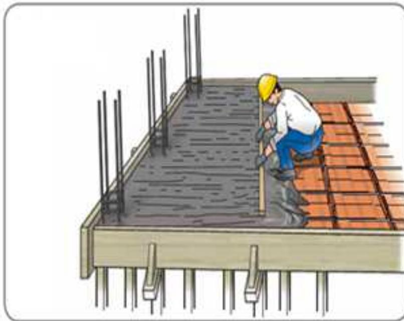
Nivelación de piso al momento de fundición de losa mediante regla metálica. (TARINGA, 2013)
