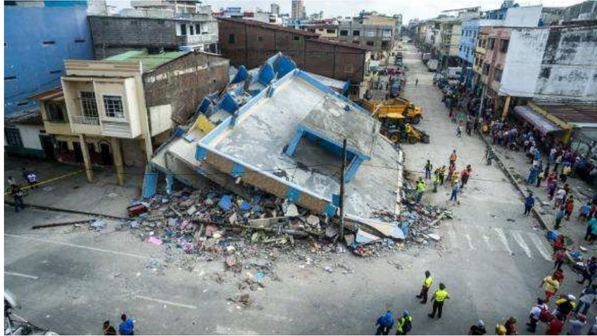
Fotografía #6. Colapso de edificio con asimetrías en planta baja en Ayacucho y García Moreno durante sismo ocurrido el 16 de Abril de 2016
