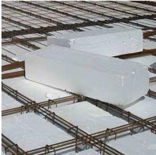
Relleno de losas aligeradas (Construyendo, 2013)
