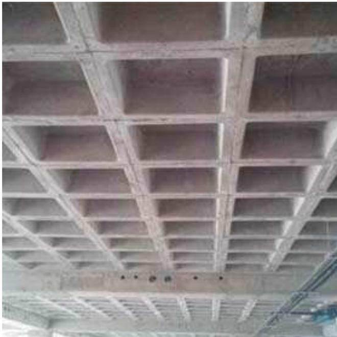
Losa aligerada fundida (Construyendo, 2013)
