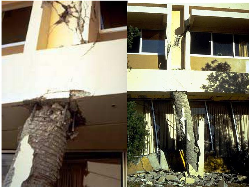
Fig. #46. Delineamiento vertical de columnas. Incorrecta secuencia de columna a diferentes niveles donde varia la geometría de su sección de circular a rectangular, las varillas longitudinales de la columna superior no coinciden con la columna inferior. (Fierro, 2004).
