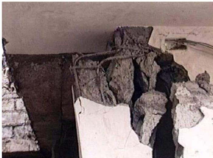
Fig. #53. Estructura con sección insuficiente, inadecuada distribución de estribos y conformación de los mismos. (DÍAZ, 2015)
