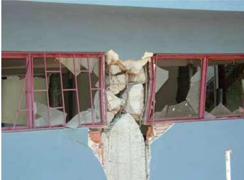
Fig. #59. Efectos de columna corta, falla por aplastamiento.
