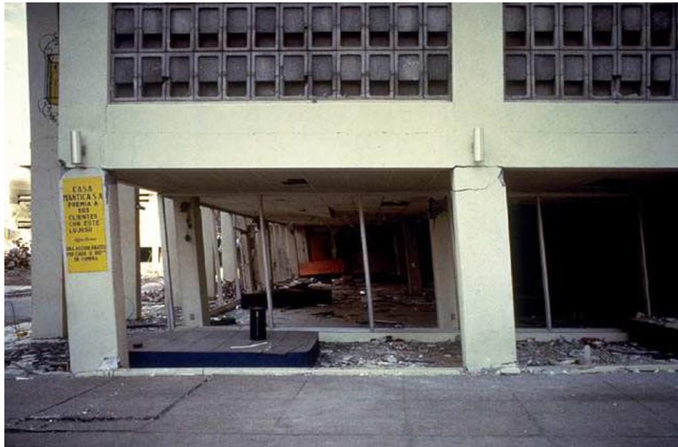
Figura #43. Se puede observar en el nivel uno con el superior se concentran esfuerzos muy grandes en las columnas que rebasan la capacidad a cortante de las ellas. (Fierro, 2004)
