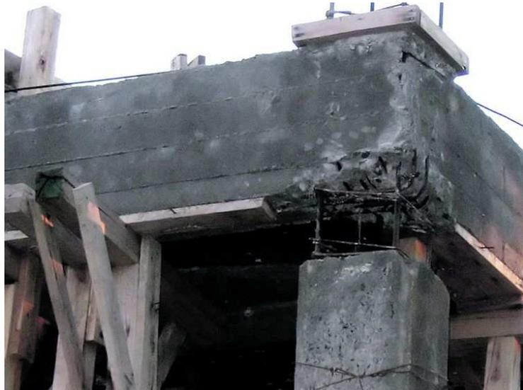
Fig. #63. Falla de conexión columna-losa provocado por sobrecarga. (Fierro, 2004)
