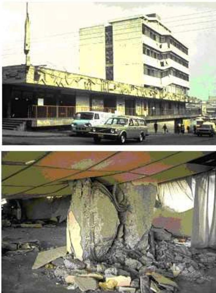
Fig. #62. Falla por cortante en columna. (LÓPEZ, 2007)
