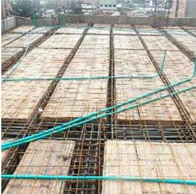
Preparación de losas antes de fundición (Construyendo, 2013)
