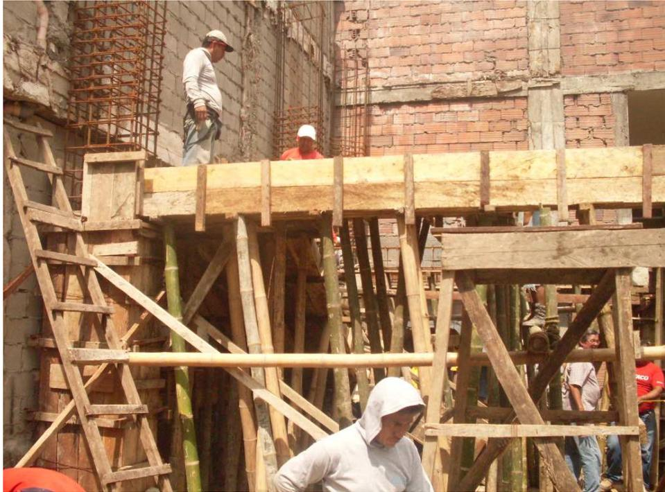
Encofrado de vigas una vez finalizada la estructuración de la misma
