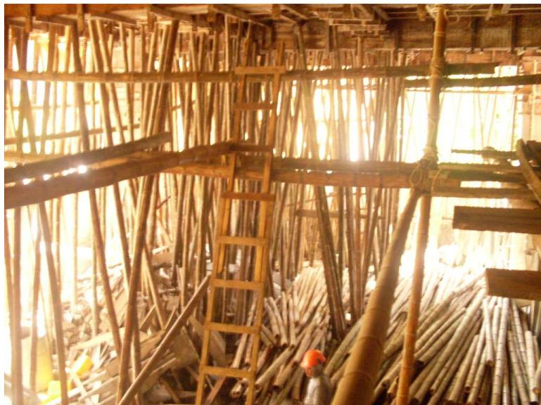
Apuntalamiento con caña y encofrado de losa con altura de 6 metros
