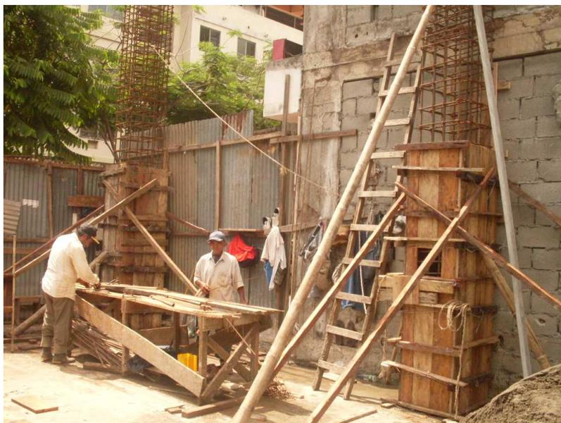
Encofrado de columnas de planta baja.
