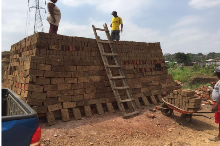
Ilustración 9. Colocación de las arenas y gravas de arcillas con adiciones de lodos residuales en el horno artesanal
