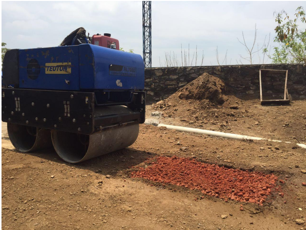
Ilustración 13. Ensayo de resistencia en terraplén
