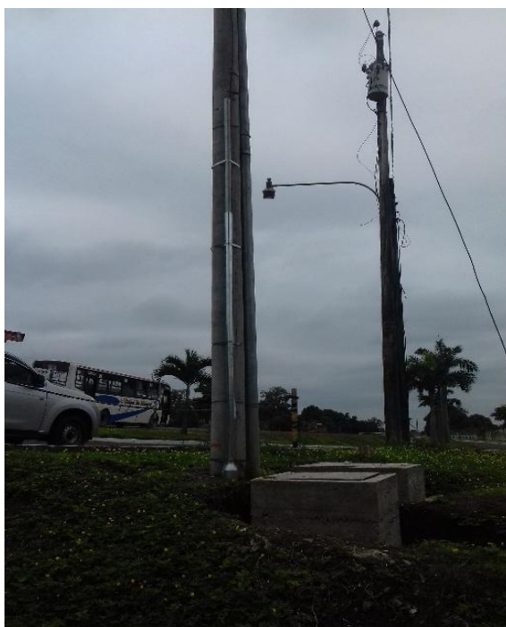
Figura 2.36: Subida a poste Fuente: El Autor
