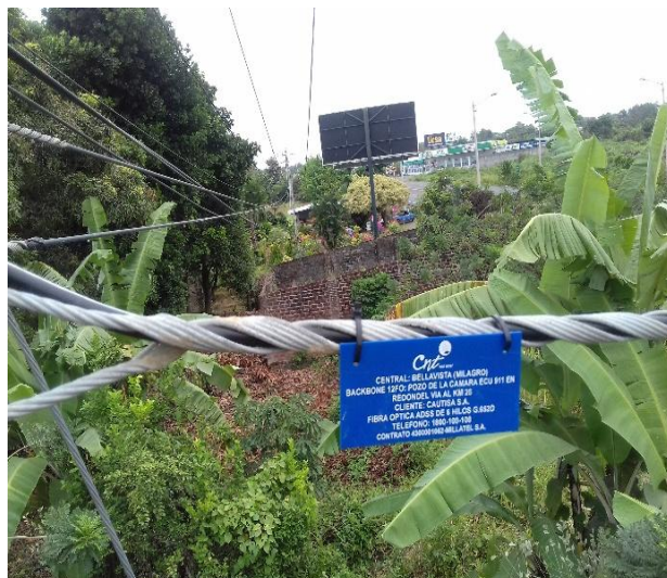
Figura 2.31: Preformado para Cable de fibra óptica ADSS Fuente: El Autor
