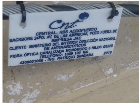
Figura 2.42: Identificador acrílico Fuente: El Autor
