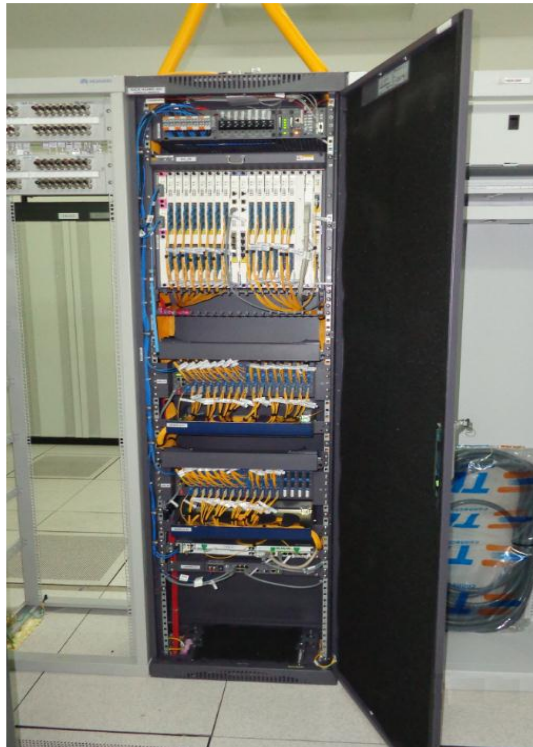
Figura 3.12: Equipo OLT Fuente: El Autor
