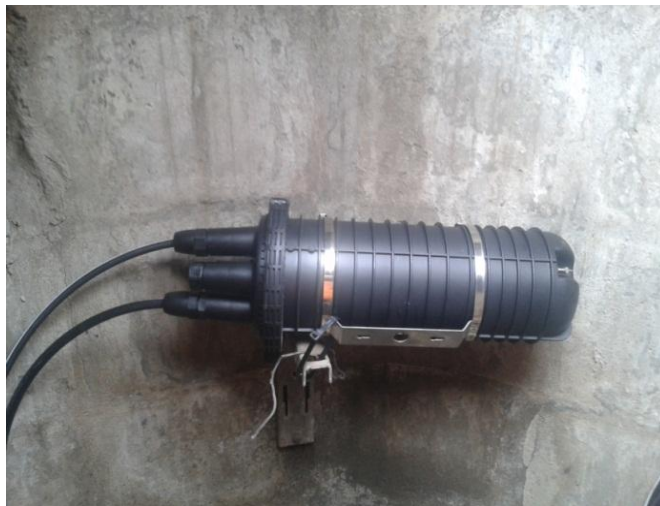
Figura 2.33: Herraje instalado en pozo Fuente: El Autor
