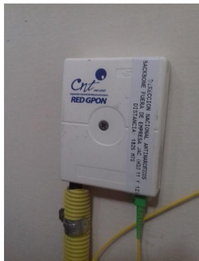
Figura 2.43: Roseta óptica Fuente: El Autor
