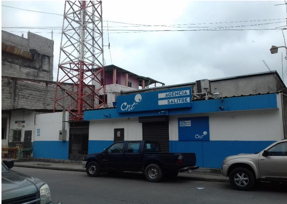
Figura 2.6: Central Telefónica Fuente: El Autor
