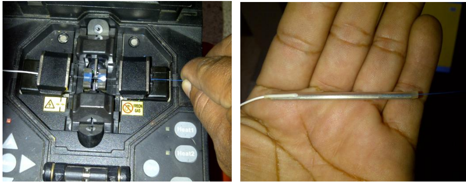
Figura 3.15: Empalme de fibra óptica (Fusión) Fuente: El Autor
