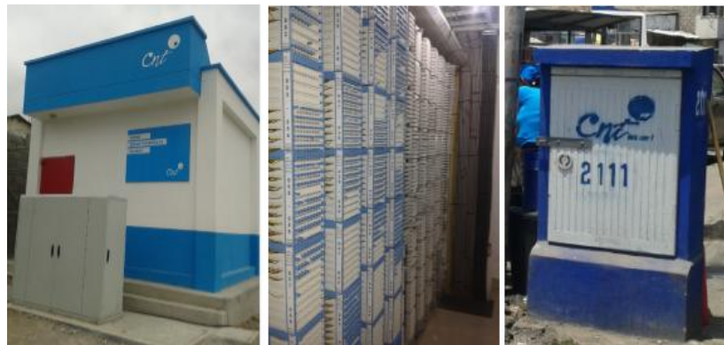
Figura 2.1: Nodo, red primaria, armario telefónico Fuente: El Autor
