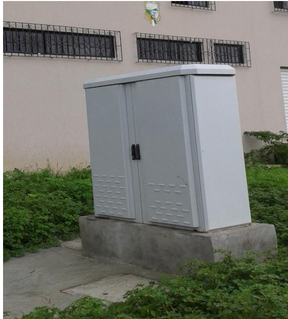
Figura 2.8: Nodo de baja capacidad Outdoor
