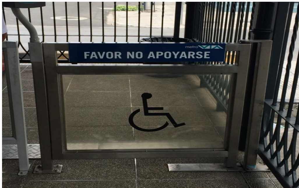
Figura 16. Puerta de acceso a Metrovía para sillas de ruedas
