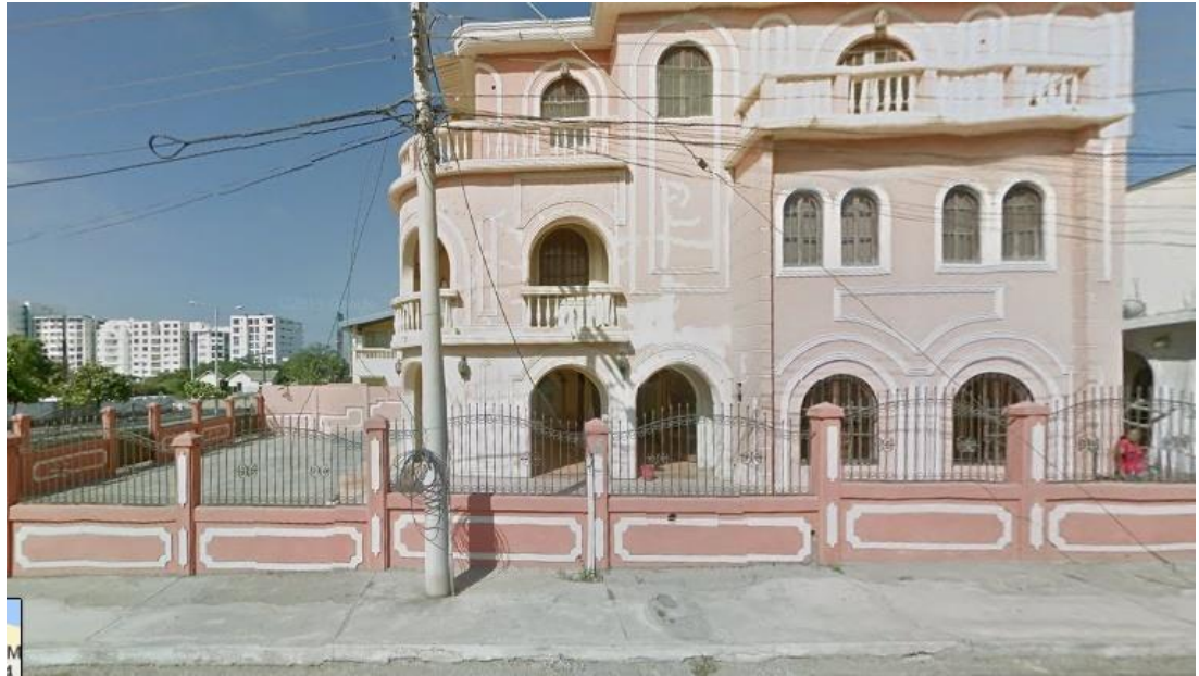
Figura 28.- Vista del edificio del lado derecho.
