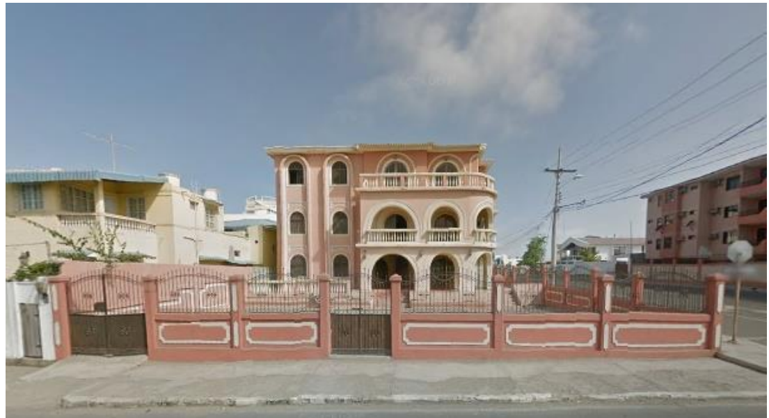
Figura 27.- Edificio en Chipipe vista de frente
