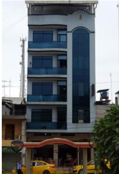
Figura 4.23 Hotel Orellana donde se ubicará el Nodo Principal del WISP. Elaborado por: Autor
