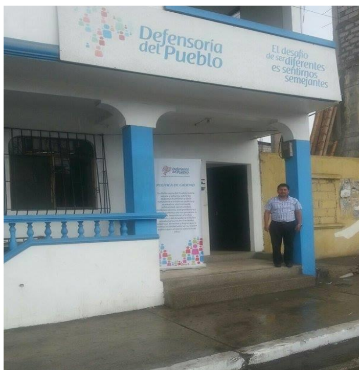
Fotografía 2.- Mostrando que en diversas ubicaciones de la Defensoría del Pueblo en el Cantón Santa Elena se encuentran las barreras arquitectónicas.
