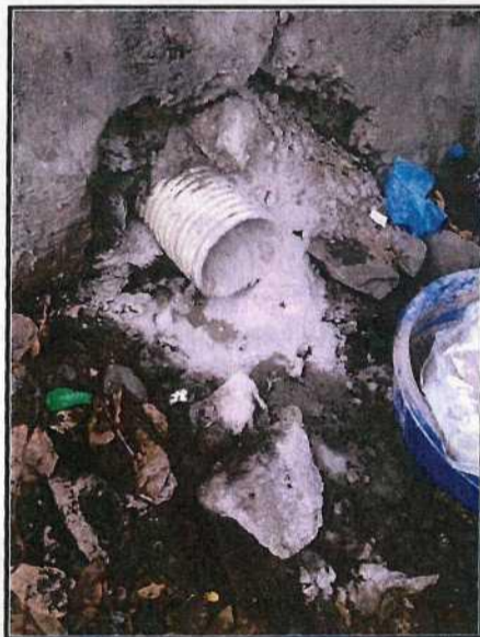
Fig. 3.9. Sellado de tubería por la empresa POLICONSTRUC S.A.
