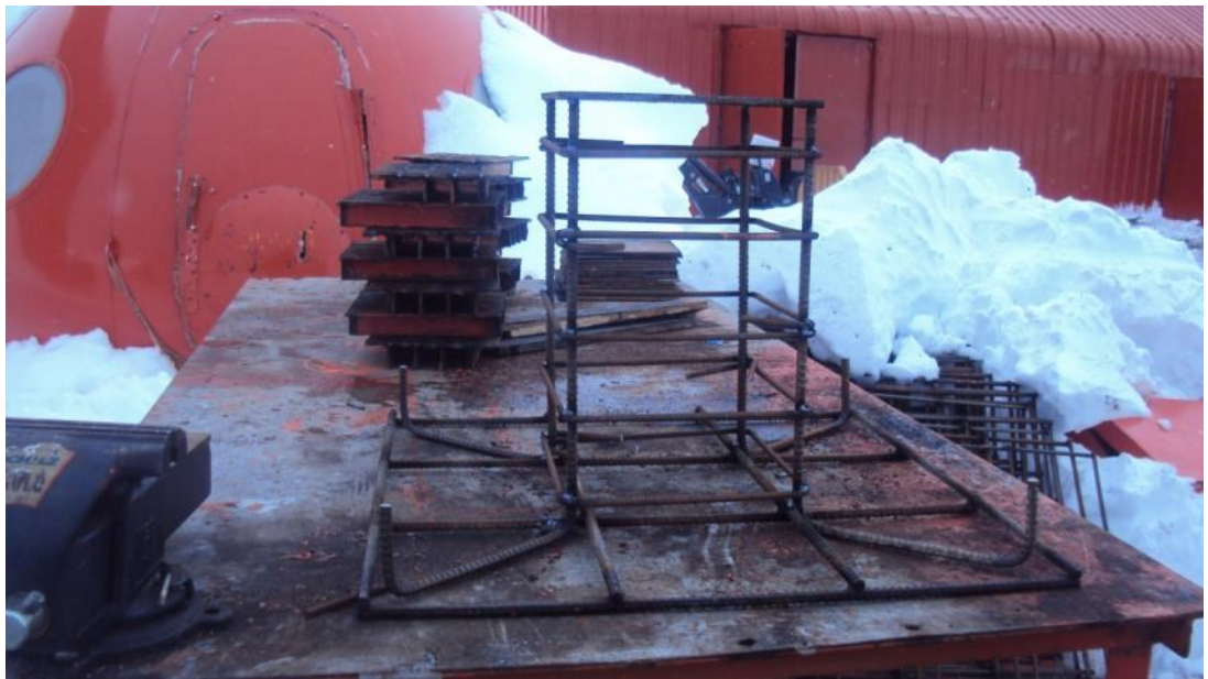
Foto 7. Estructura del plinto
