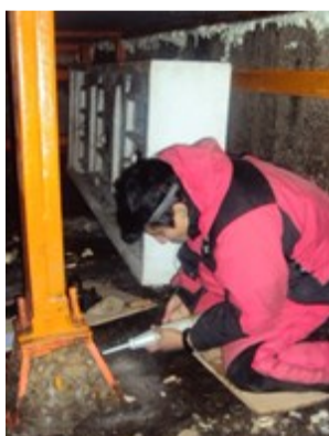
Foto 27. Pruebas no destructivas con Esclerómetro a los Módulos 1, 2 y 3.
