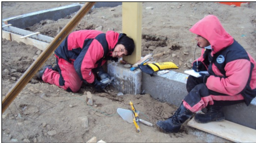
Foto 28. Toma de Resistencia a la Compresión
