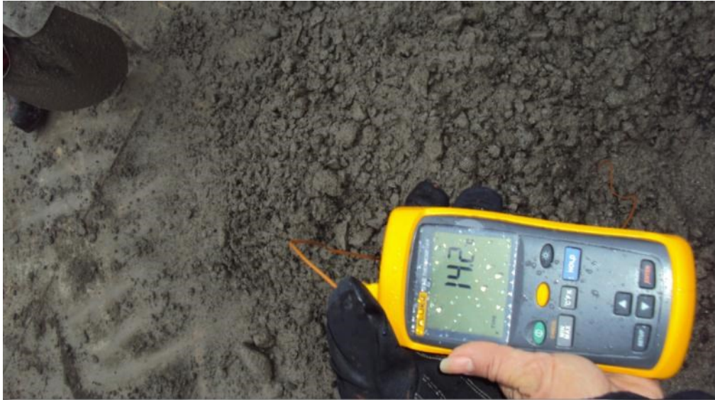
Foto 13. Lectura de la Temperatura del Hormigón.
