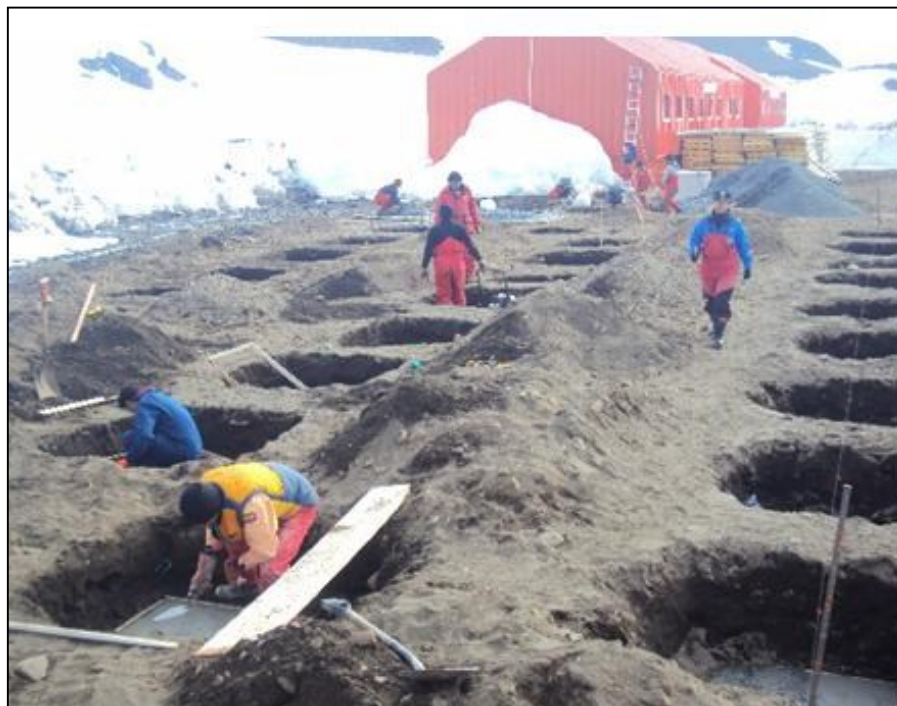
Foto 10. Fundición de Replantillo
