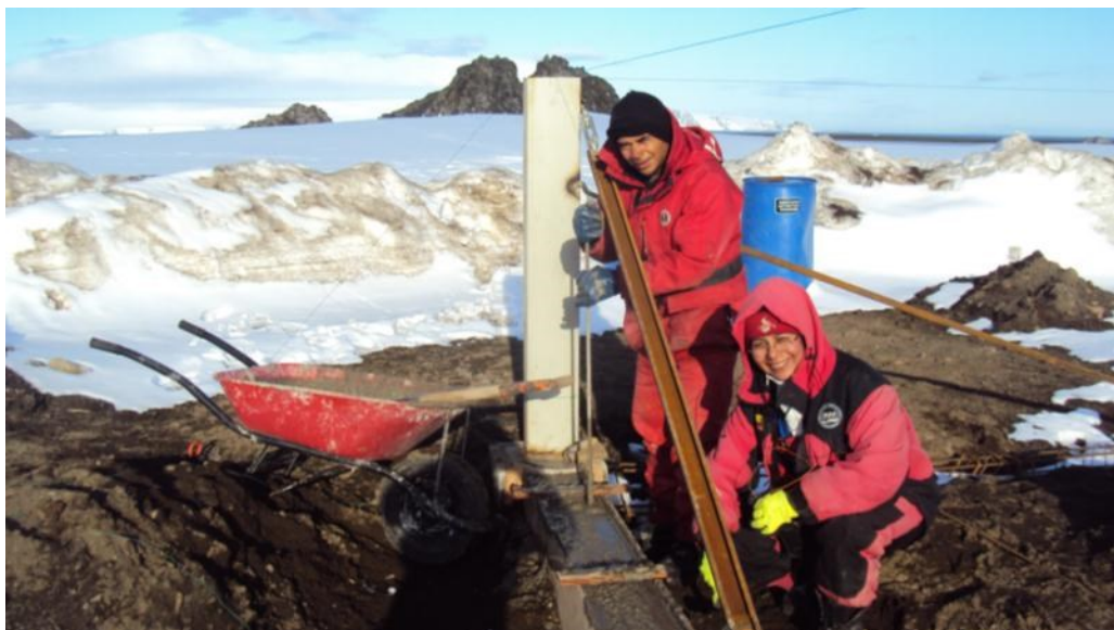
Foto 17. Fundición de Riostras del Módulo 4. CPNV-CSM Patricia Torres y SUBS-HI Molina.
