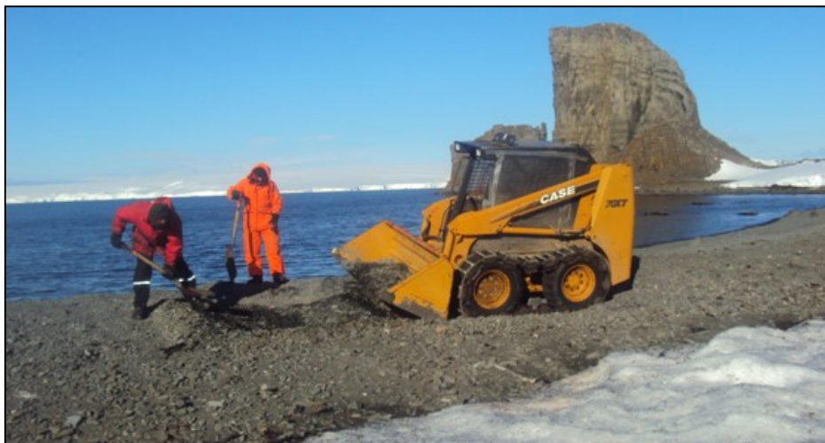
Foto 19. Transporte de Agregado de Caleta Jambelí.
