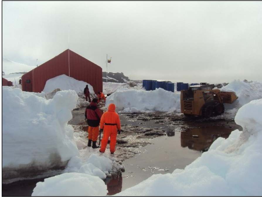
Foto 4. Limpieza de Terreno para Construcción del Módulo 4.
