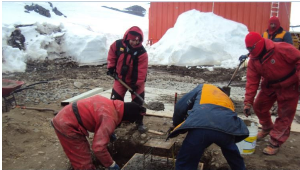
Foto 14. Fundición de Plintos
