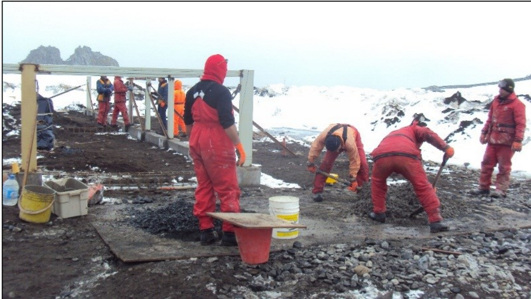
Foto 16. Preparación Manual del Hormigón
