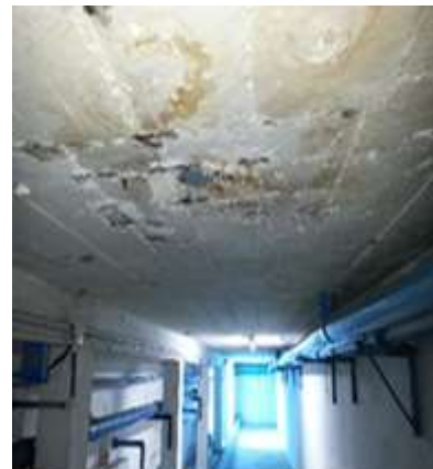
Figura 12: Cuarto de bombas
