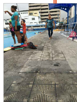
FIGURA 70: CORREGIR NIVEL DE TAPA DE CAJA DE REGISTRO, REPOSICIÓN DE REJILLA
