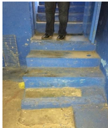
Figura 74: Cuarto de bomba piscina Asisclo Garay
