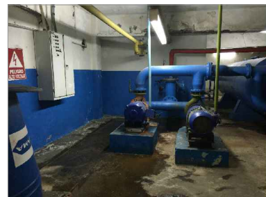
FIGURA 77: BASE METÁLICA DE LOS MOTORES CON OXIDO Y CORROSIÓN
