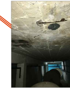
FIGURA 40: HUMEDAD EN LOSA DESPRENDIMIENTO DE HORMIGÓN
