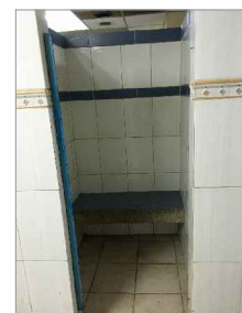
FIGURA 87: REPOSICIÓN DE PUERTA
