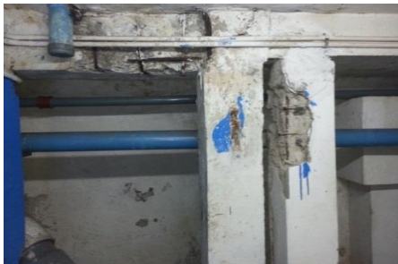
Figura 26: Cuarto de bomba piscina Vallarino
