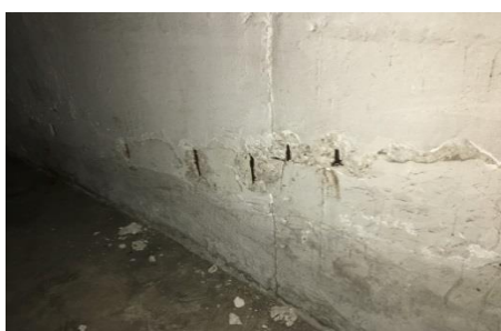
Figura 28: Cuarto de bomba piscina Vallarino
