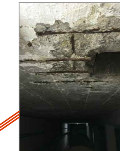
FIGURA 39: HUMEDAD EN LOSA DESPRENDIMIENTO DE HORMIGÓN
