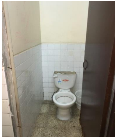
Figura 97: Baños públicos ingreso
