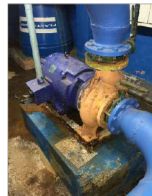
FIGURA 76: DESPRENDIMIENTO DE HORMIGÓN HIERRO EXPUESTO A LA HUMEDAD
