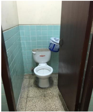
Figura 94: Baños públicos ingreso
