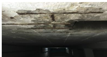
Figura 39: Cuarto de bomba piscina Vallarino
