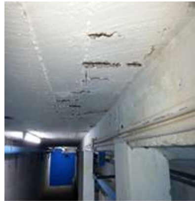
Figura 14: Cuarto de bombas Fuente: Cedeño, (2015)
