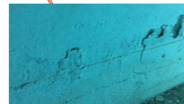
FIGURA 32: DESPRENDIMIENTO DE HORMIGÓN
