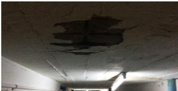
Figura 45: Cuarto de bomba piscina Vallarino
