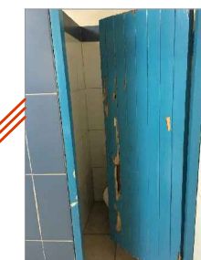
FIGURA 90: PUERTAS DE MADERA HOJA Y BATIENTES CON POLILLAS
