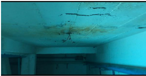
Figura 43: Cuarto de bomba piscina Vallarino
