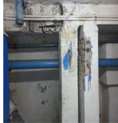
Figura 13: Cuarto de bombas Fuente: Cedeño, (2015)
