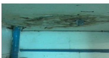
Figura 38: Cuarto de bomba piscina Vallarino
