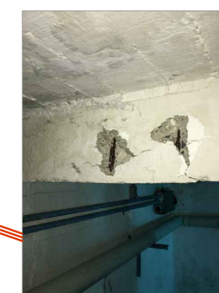
FIGURA 32: DESPRENDIMIENTO DE HORMIGÓN
