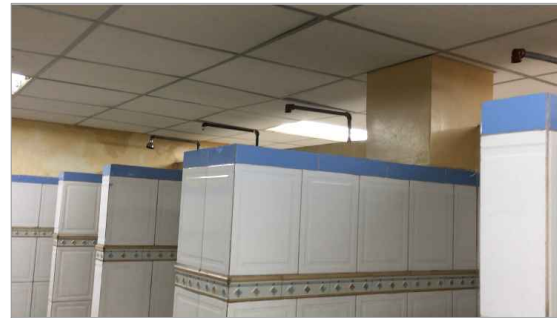
FIGURA 80: DUCHAS EN MAL ESTADO: CAMBIO DE GRIFERÍA
