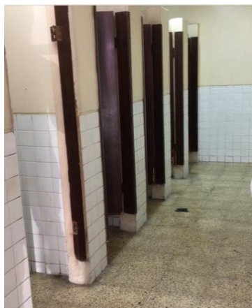
Figura 98: Baños públicos ingreso
