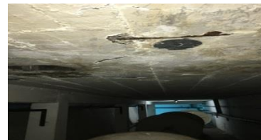
Figura 40: Cuarto de bomba piscina Vallarino
