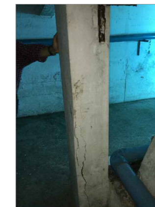
FIGURA 30: ENLUCIDO DE COLUMNA CON FISURAS
