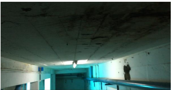
Figura 44: Cuarto de bomba piscina Vallarino
