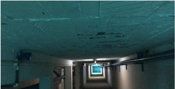
Figura 46: Cuarto de bomba piscina Vallarino
