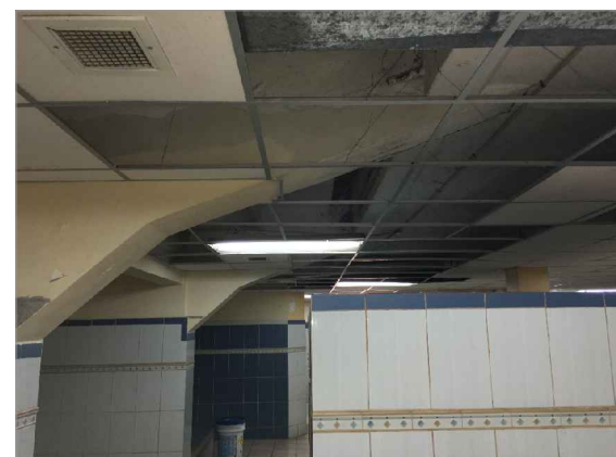
FIGURA 92: REPOSICIÓN DE PLANCHAS EN TUMBADO
