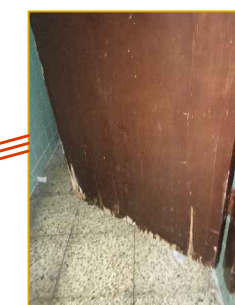
FIGURA 95: PUERTAS DE MADERA CON POLILLAS
