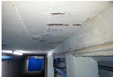
Figura 34: Cuarto de bomba piscina Vallarino
