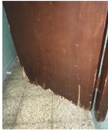
Figura 95: Baños públicos ingreso
