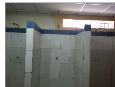
FIGURA 89: REPOSICIÓN DE GRIFERÍA EN DUCHAS
