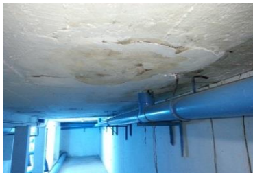
Figura 35: Cuarto de bomba piscina Vallarino
