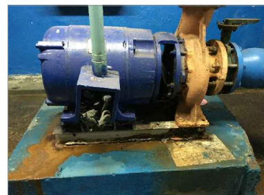
FIGURA 77: BASE METÁLICA DE LOS MOTORES CON OXIDO Y CORROSIÓN
