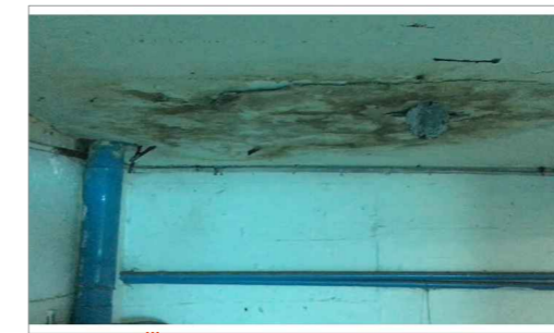
FIGURA 39: HUMEDAD EN LOSA DESPRENDIMIENTO DE HORMIGÓN
