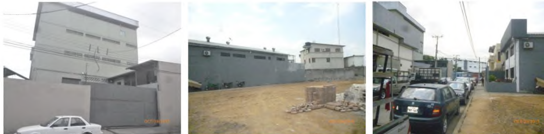
Fotos de entorno cercano, altura en pisos y edificación adosada
