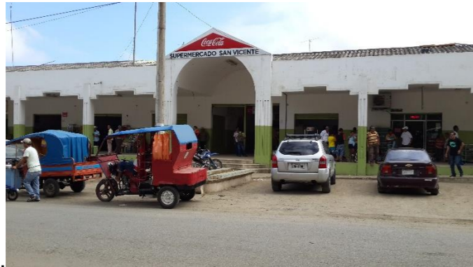
Ilustración 6: Mercado existente en el terreno del proyecto Fuente: Rivas, K; 2014
