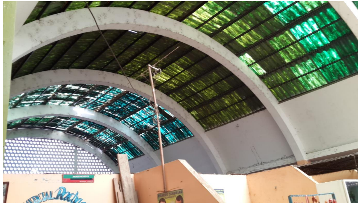
Ilustración 22: Cubierta de mercado Fuente: Rivas, K.2014.
