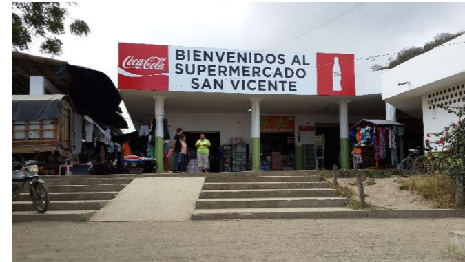
Ilustración 7: Mercado existente en el terreno del proyecto Fuente: Rivas, K; 2014
