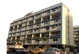
Figura: Bloques Multifamiliares del IESS Fuente: Sigüenza (2013)
