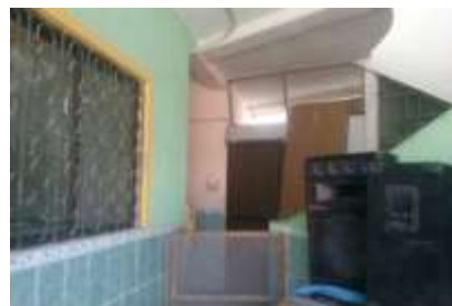
Figura 2: escalera del bloque c Fuente: elaboración propia
