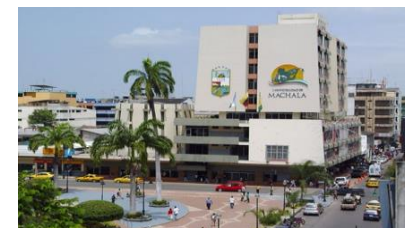
Figura 15: Fachada GAD Municipal de Machala Fuente: GAD Municipal de Machala (2015)
