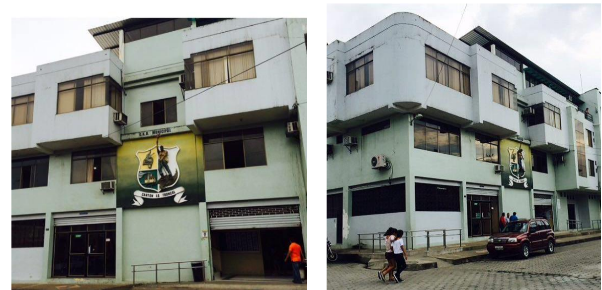
Figura 2: Fachada frontal del GAD Municipal de La Troncal
