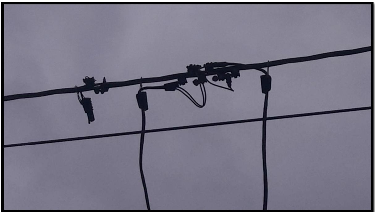
Fig.15 Acometidas del Sistema preensamblado.
