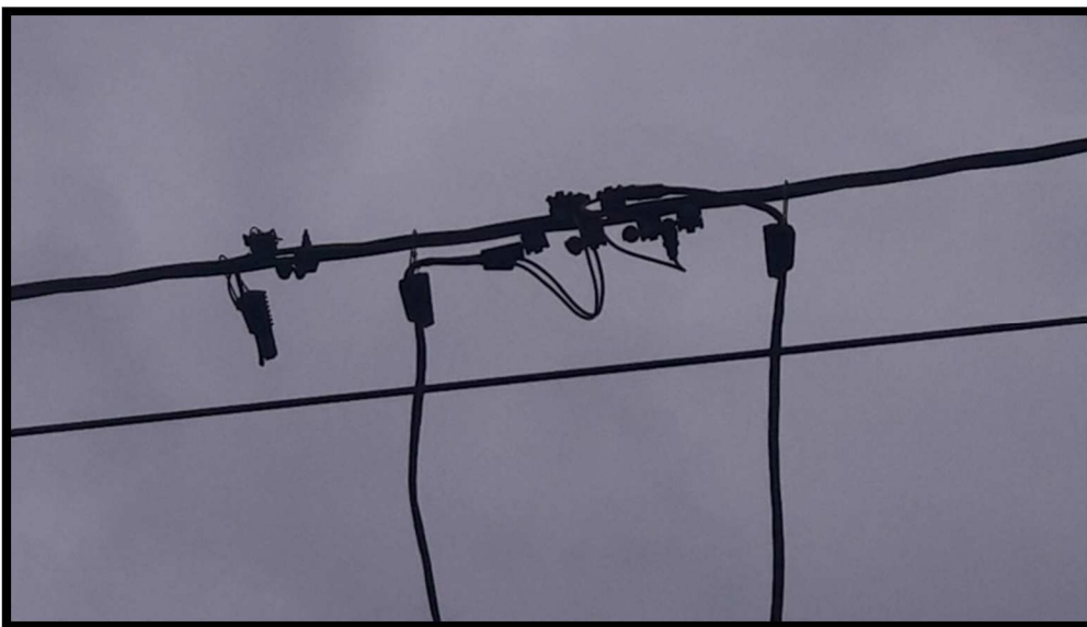
Fig.15 Acometidas del Sistema preensamblado.
