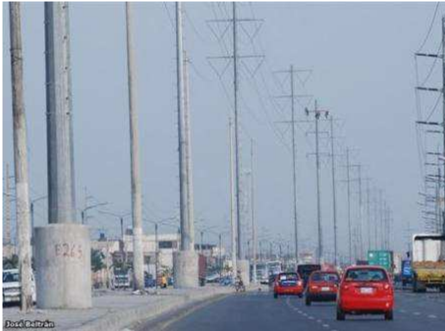
Fig.9 Líneas de transmisión
