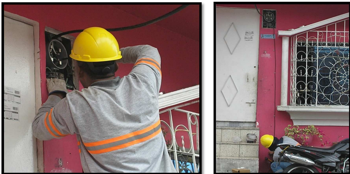
Fig.35 Instalación de Base Socket y Puesta a Tierra
