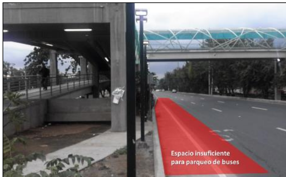
Figura 5.10 Paradero que es inutilizado por contar con poco espacio de parqueo
