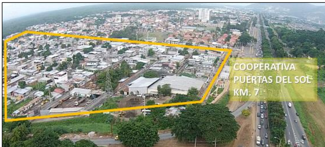
Figura 3.13 Vista Panorámica de Cooperativa Puertas del Sol
