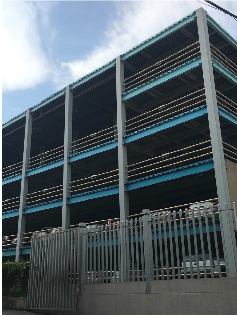
Figura 28: Vista Frontal del Parqueadero de la Judicatura (Fuente: Procel, 2015)
