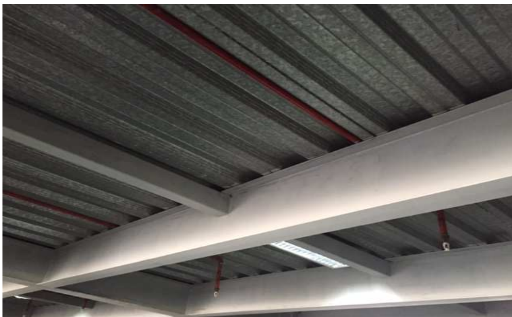
Figura 22: Losa, vigas secundarias, diafragmas (Fuente: Procel, 2015)
