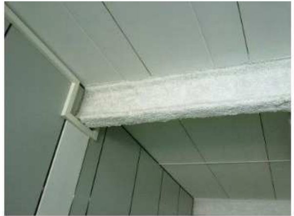
Protección con Mortero de lana de roca
