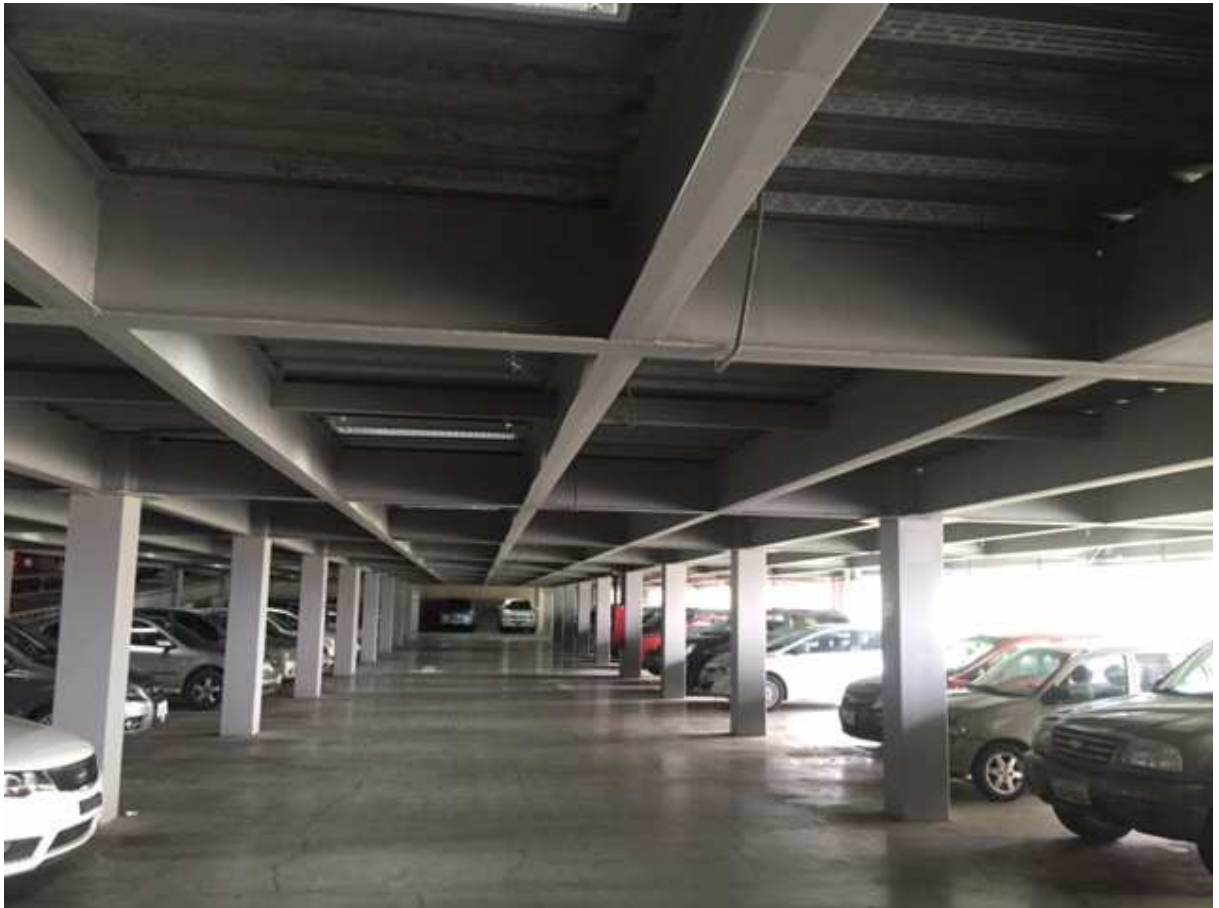
Figura 24: Vista Frontal de vigas principales perpendiculares (Fuente: Procel, 2015)
