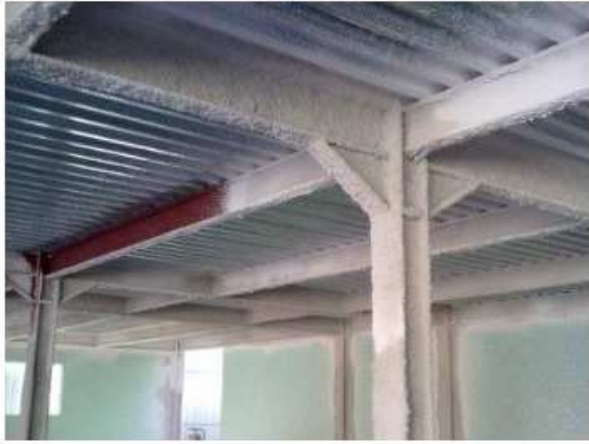
Protección con Mortero de perlita o vermiculita
