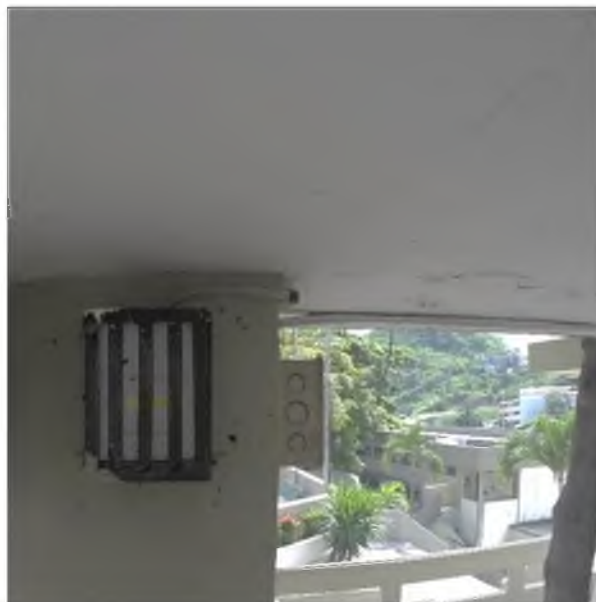
Figura 3. 22: ZoneFlex Ruckus 7025 Bloque de Laboratorios Fuente: (García Gamboa, 2015)
