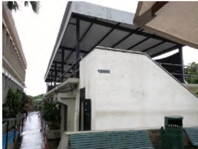
Figura 3. 4: Bloque #1 Laboratorios de Automatismo Fuente: Los Autores
