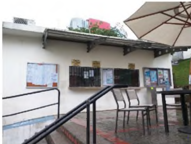
Figura 3. 2: Bloque Administrativo de la Facultad Técnica Fuente: Los Autores
