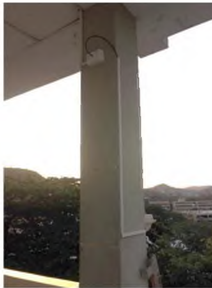
Figura 4. 13: Punto de datos en pilar del Bloque # 4
