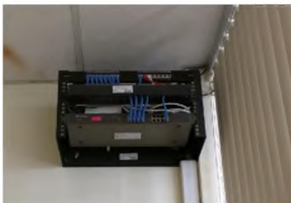
Figura 4. 16: Rack aéreo de la sala de profesores de tiempo completo
