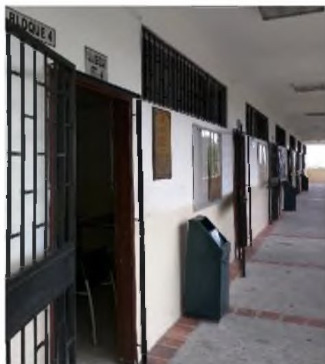
Figura 3. 7: Bloque #4 Aulas y Sala de Profesores Fuente: Los Autores
