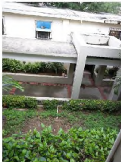
Figura 4. 10: Tubería para el punto de datos fuera la sala de cómputo
